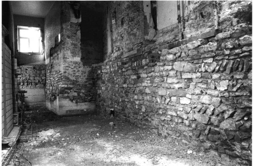
5: Die freigelegten Fundamente der Burkhard'schen Stadtmauer und des zugehörigen Eckturms im Lohnbhof hinter der Leonhardskirche.
