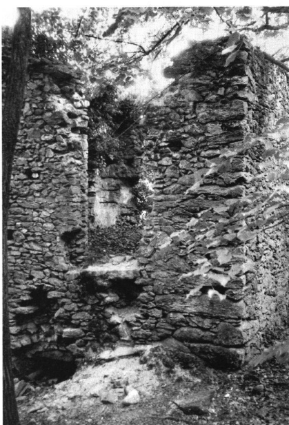
8: Ansicht der Nordseite mit dem erhöhten Zugang zum Obergeschoss. Links unten ist der Kellereingang erkennbar.
