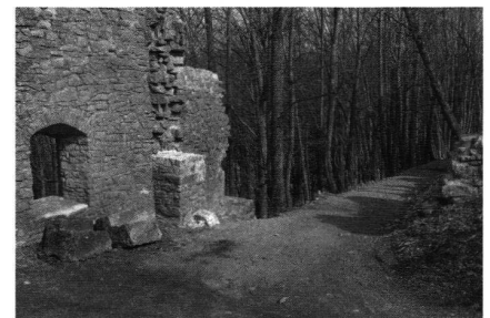
14: Zugangsbereich (K) 2004, Burgtor an Mauer M23 mit Bogenstücken, von Südwesten.
