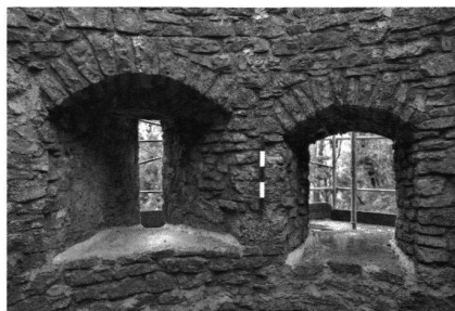
13: «Pulverturm» (L) 2003, 1935 rekonstruiertes Schartenfenster (links) und Schlüsselscharte ohne Leibung (rechts) im 1. Obergeschoss, von Norden.
