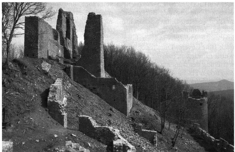
21: Die Burgruine nach der Sanierung 2003, von Westen.
