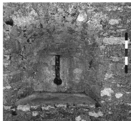
17: «Geissturme» (N) 2003, erhaltene Schlüsselscharte im 1. Obergeschoss, von Westen.
