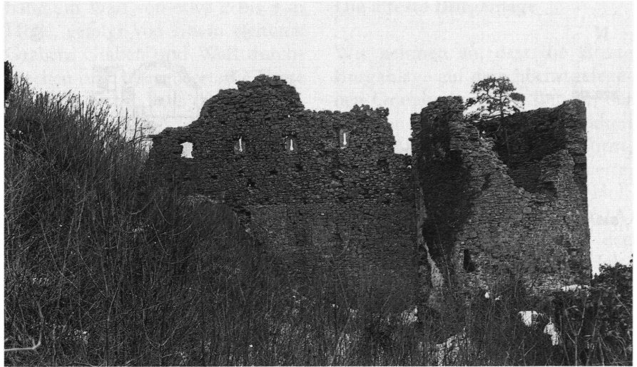
15: «Geissturm» (N) und Umfassungsmauer M48 mit Webrgang Ende 19. Jb., von Westen.
