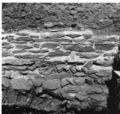
7: Ansicht der Mauer M2 von Westen in Sondierschnitt S1.
