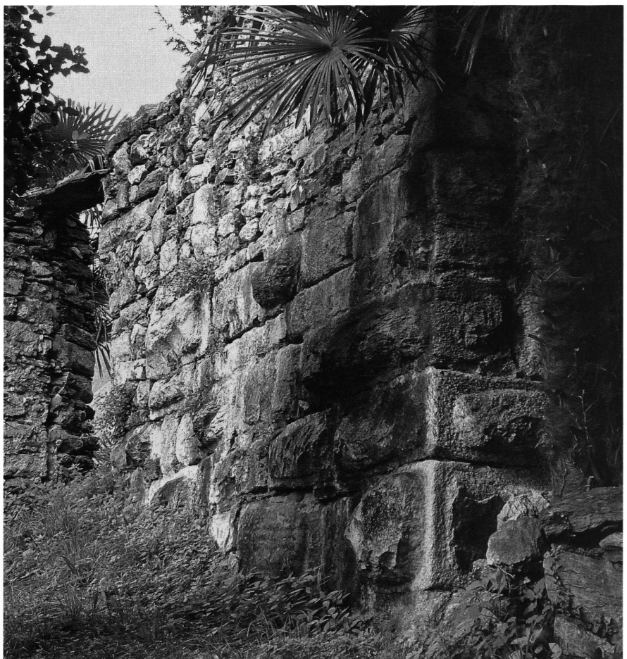
12: Ansicht der südöstlichen Turmecke von Osten, mit Buckelquader im Sockelbereich.
