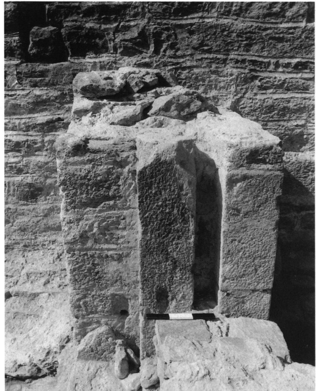
8: Serravalle. Wange des äusseren Tores im Raum X. Gut erkennbar die Nut für ein Fallgatter und der Falz mit Loch der Angel für den Torflügel. Gut erhaltener, originaler Rasa-pietra -Putz mit horizontalem Fugenstrich (2004).
