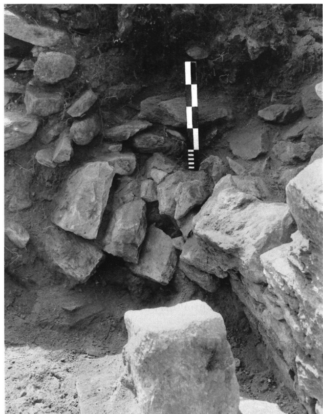
24: Serravalle. Zwingermauer von Raum X. Deutlich erkennbar das durch den Zerstörungsschutt von 1402 nach aussen verschobene Mauergefüge (2004).
