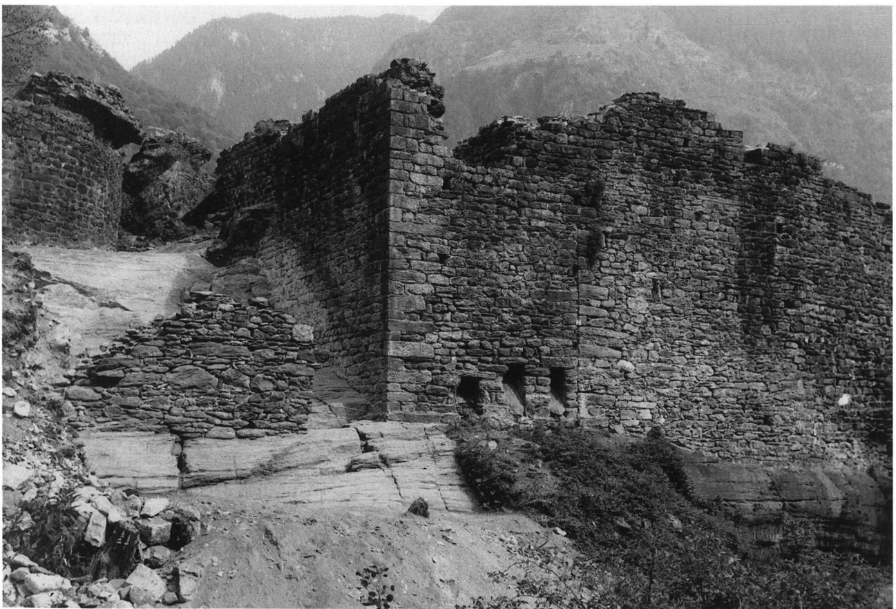
3: Serravalle. Hauptburg, Ansicht von Nordwesten. Blick gegen den Latrinenanbau L (2003).
