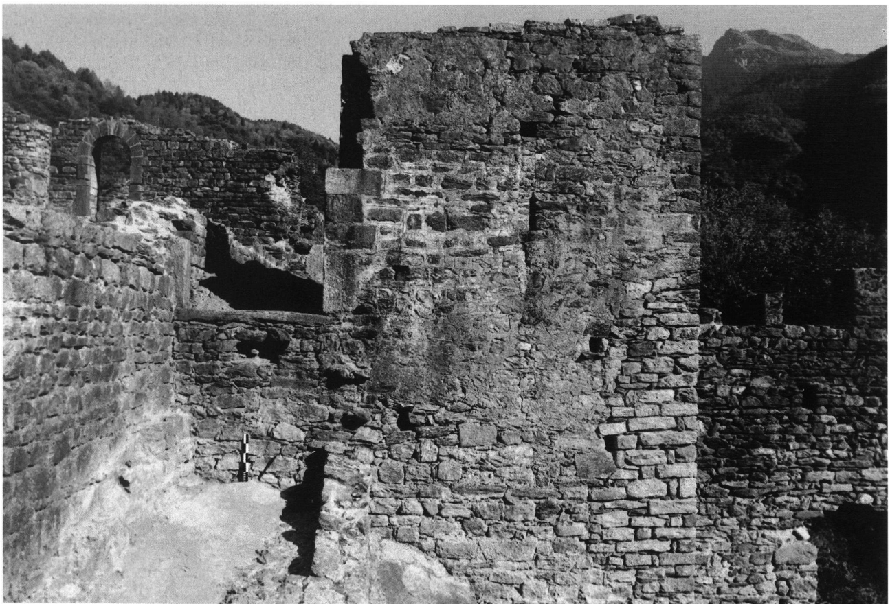
5: Serravalle. Jüngerer Torbau D, Ansicht von Südosten. Im Vordergrund Reste des Aufstiegszwingers. Im Bereich der Toröffnung und des Eckverbandes zeigt das Mauerwerk starke Eingriffe von 1928/30 (2003).
