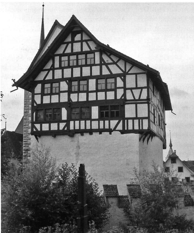
Burg Zug Ostfassade.
