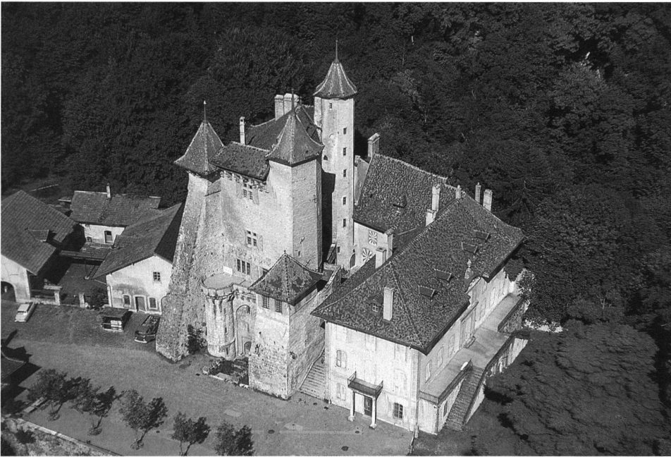
18: Vue aérienne du château de Vaumarcus – Luftbild von Vaumarcus.
