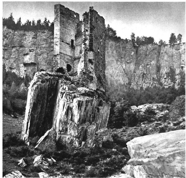
9: Haldenstein GR. Ansicht von Osten. Bei einem Erdbeben 1787 brach eine bedeutende Partie des Felsens ab und riss Teile des an den Bergfried angebauten älteren Wohntraktes in die Tiefe. Der jüngere Wohntrakt war bereits 1769 und 1771 bei Felsabbrüchen unbekannter Ursache eingestürzt.
