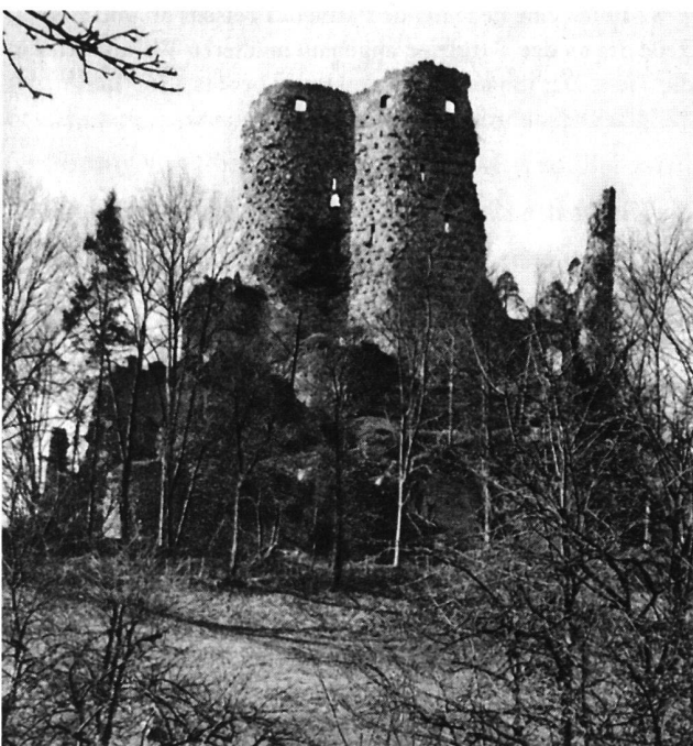
10: Pfeffingen BL. Ansicht des Wohnturms von N, vor und nach dem Teileinsturz bei einem Beben 1867.
