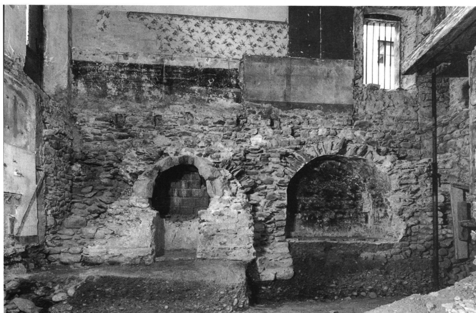
12: Rue des Deux-Marchés n° 34, murs 5 (pont) et 7 (four). – Mauer 5 (Brücke) mit zwei Brückenbögen. In den westlichen (linken) wurde nachträglich der Backofen 7 eingebaut.
