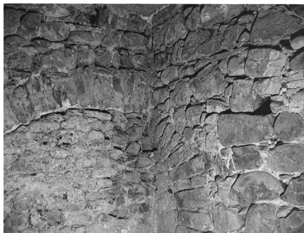
8: Rue des Deux-Marchés n° 34, rez-de-chaussée, local sud-est, jonction des murs 14 et 22. – Erdgeschoss, Raum Südost. Anschlüsse der Mauern 14 (links) und 22 (rechts).
