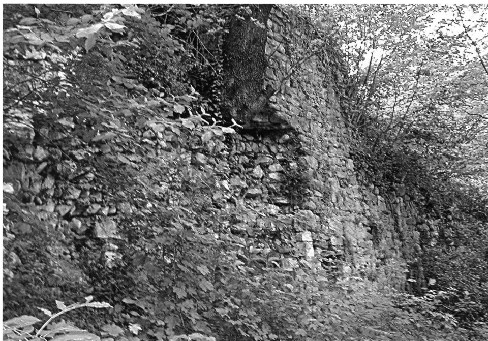
5: Castel San Pietro. Tratto del muro di cinta – Reste der Umfassungsmauer der Burg von Castel San Pietro.
