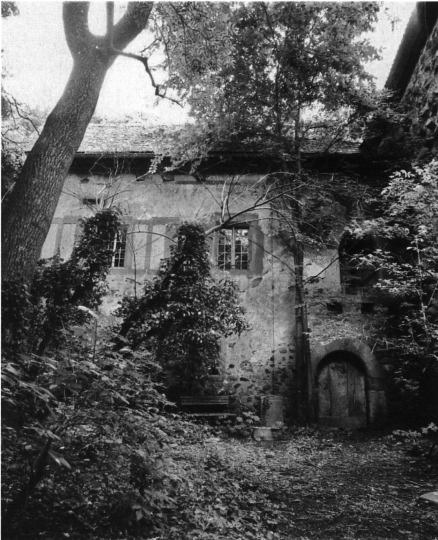
5: Der völlig zugewachsene Unterhof von Osten her gesehen, kurz vor Beginn der Umbauarbeiten 1988.
