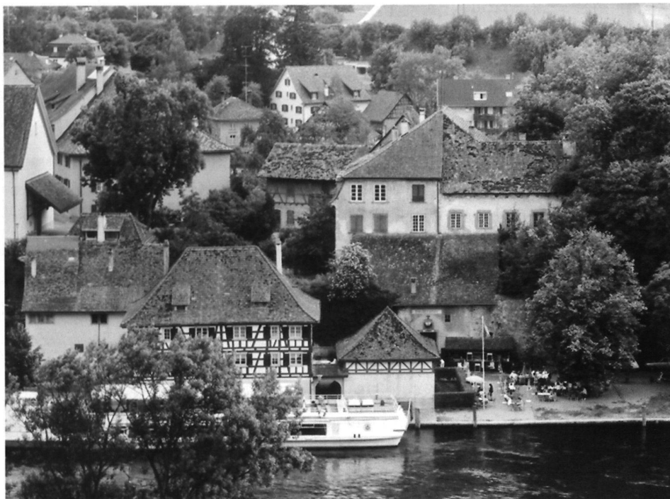
2: Blick von Norden auf den Unterhof kurz vor Beginn der Umbauarbeiten 1988.
