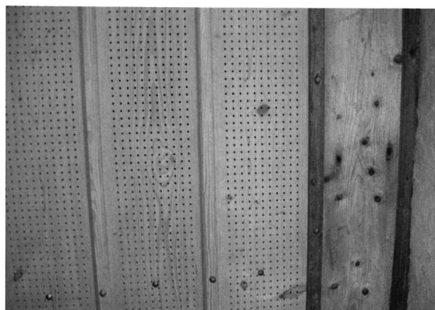
9: Die «schallsanierte» Decke im Rittersaal.
