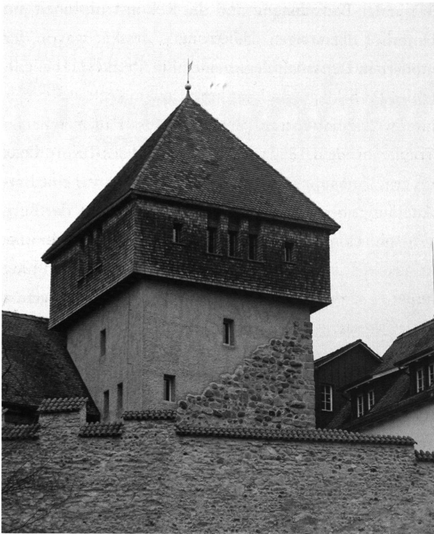
12: Übergang vom originalen zum ergänzten Mauerwerk am Turm.
