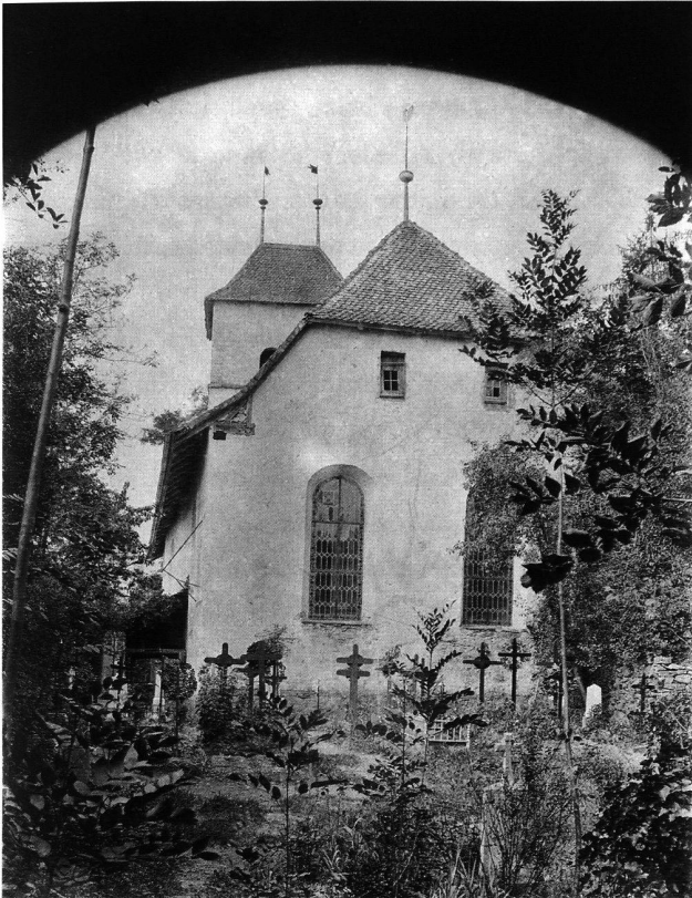
2: Der Friedhof im ehem. Burghof. Zustand vor Sanierung von 1946/49.
