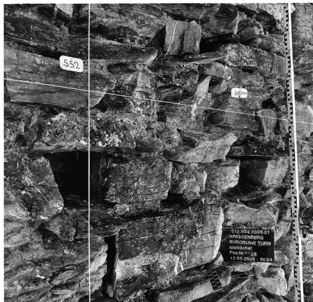
2: Nischen im Befundzustand. Deutlich sichtbar sind die leicht vorkragenden Dach- und Sohlplatten.
