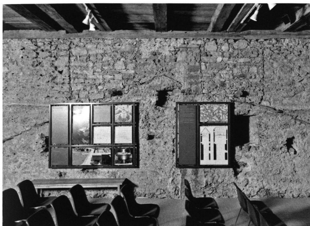
10: Bergfried 5. OG. Südmauer mit Wasserschlag und Pfettenlöchern des Giebeldaches. Darüber Zinnen mit zugemauerten Lücken. Am Zinnenansatz der horizontale Mörtelkragen des Taschendaches.
