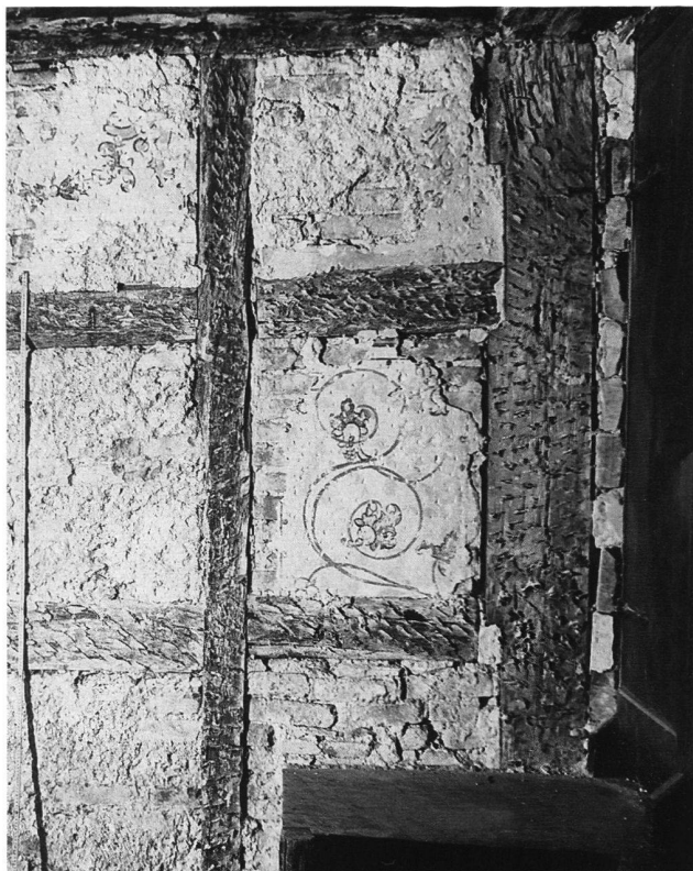
16: Mit Bollenfries gefasste Rankenmalerei im Riegelfeld an der Nordwand im Gang des zweiten Obergeschosses, während der Umbauarbeiten 1959–1960.
