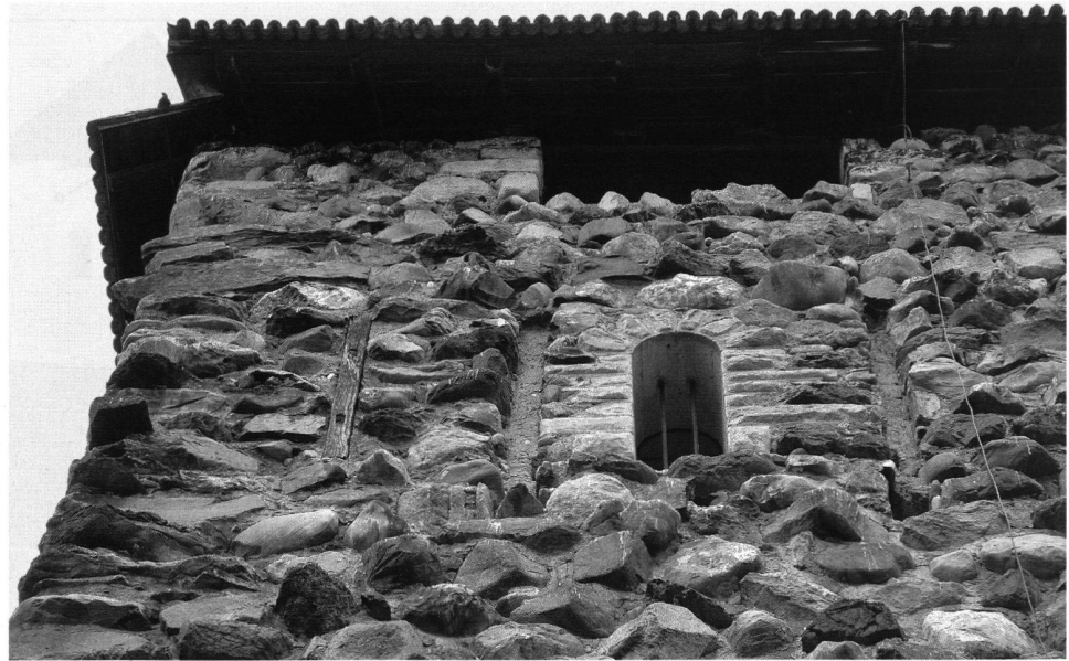
6: Turm, 1. Obergeschoss, nördliche Rundbogenöffnung mit seitlichen Balkennegativen und drei Balkenlöchern (unten).
