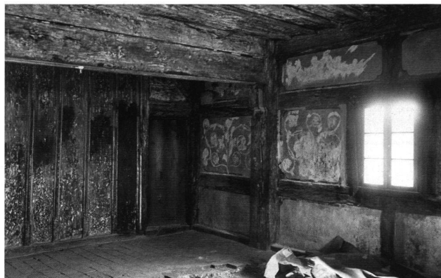
14: Die mit dem Riegelobergaden verbundene Holztäferwand mit gotisch profilierten Leisten im südwestlichen Zimmer, zweites Obergeschoss. Auf den Riegelfeldern wurde eine Rankenmalerei angebracht. Fotografie 1936.
