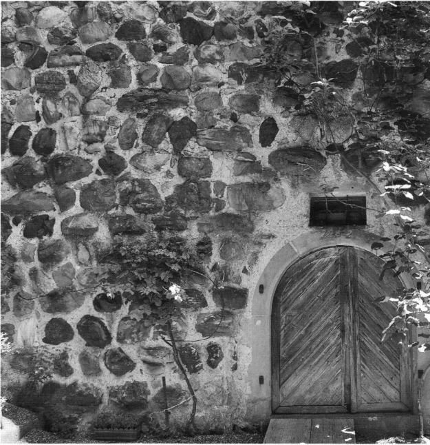
4: Detail der Turmwestfassade mit Rundbogenportal von 1552.
