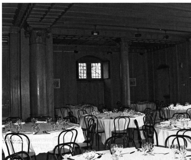
17: Grand salle à manger au rez-de-chaussée, avec les colonnes en copie de Chillon. Der grosse Speisesaal im Erdgeschoss mit Säulenkopien aus Schloss Chillon VD.
