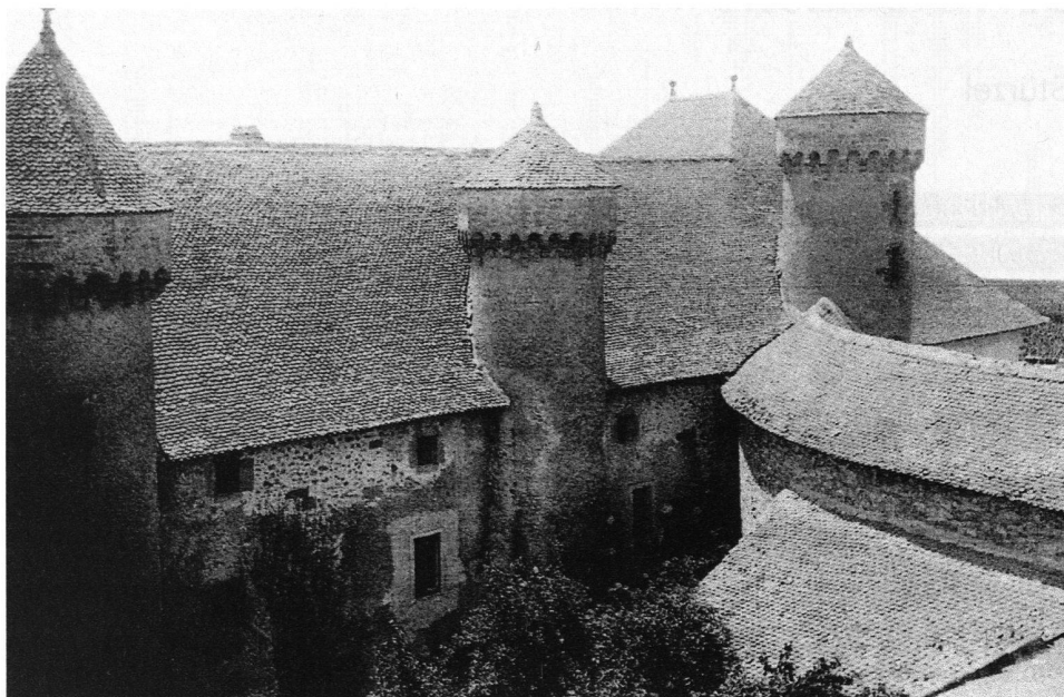
1: Le château d'Amédée avec l'église baroque et ses annexes dans la cour avant sa démolition en 1892. Die Burg von Amadeus VIII. von Savoyen mit der Barockkirche und weiteren Anbauten im Hof, im Zustand vor dem Abbruch der Kirche 1892.
