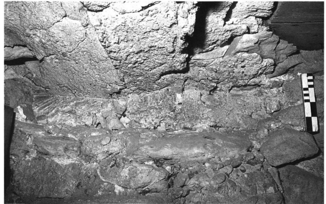
13: Mörtelnegative der herausgerissenen hölzernen Sturzbalken hinter der Türe des Hocheingangs; von E.
