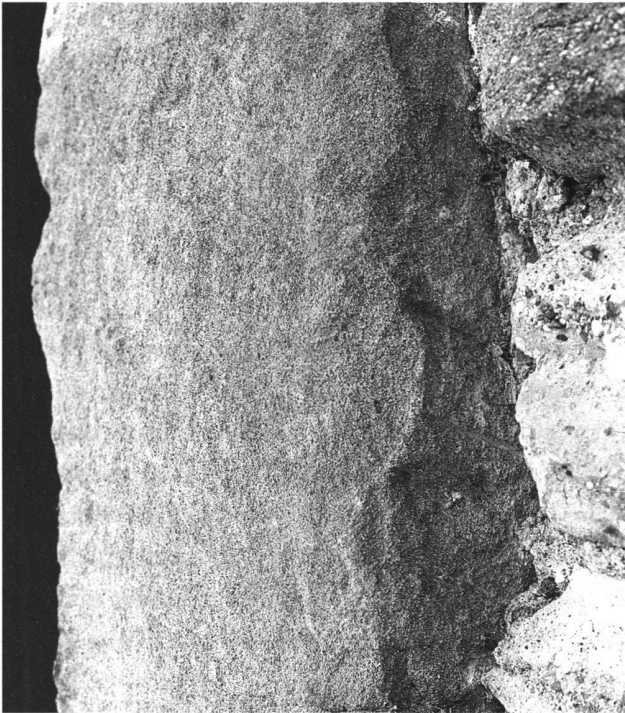
12: Auffällige Bruchkante von der Steinbearbeitung am untersten Stein des östlichen Türpfostens des Hocheingangs; von SE.
