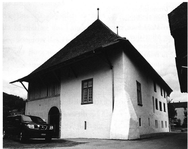
9: Die Nordfassade. Zwei (rekonstruierte) grosse Kreuzstockfenster markieren die Position des grossen Festsaals von 1526–30. Links der neue Ökonomietrakt von 2007.
