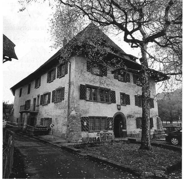
2: Das Grosse Höchhus vor der Sanierung. Aufnahme 2006.
