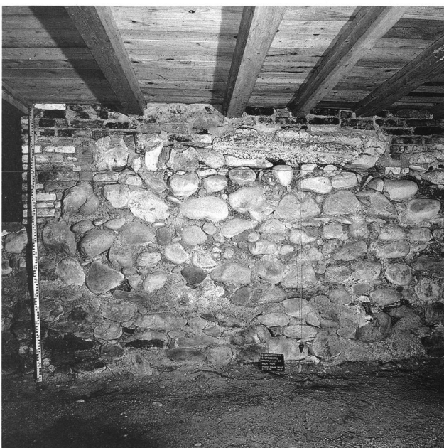
4: Mauerreste der nordseitigen Ringmauer der Phase II.
