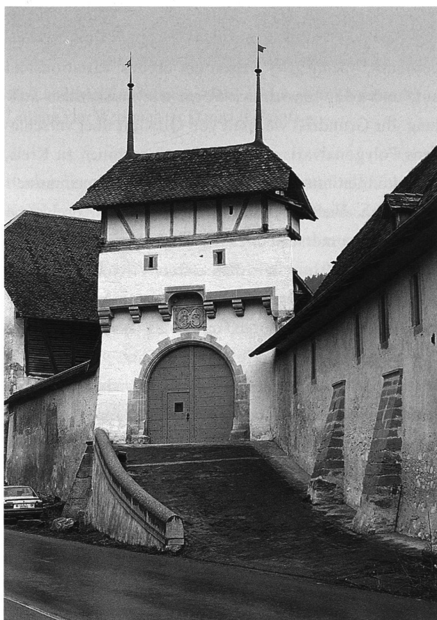
6: Oberdiessbach, Torturm des Alten Schlosses, errichtet 1556. Zustand nach der Restaurierung von 1994.
