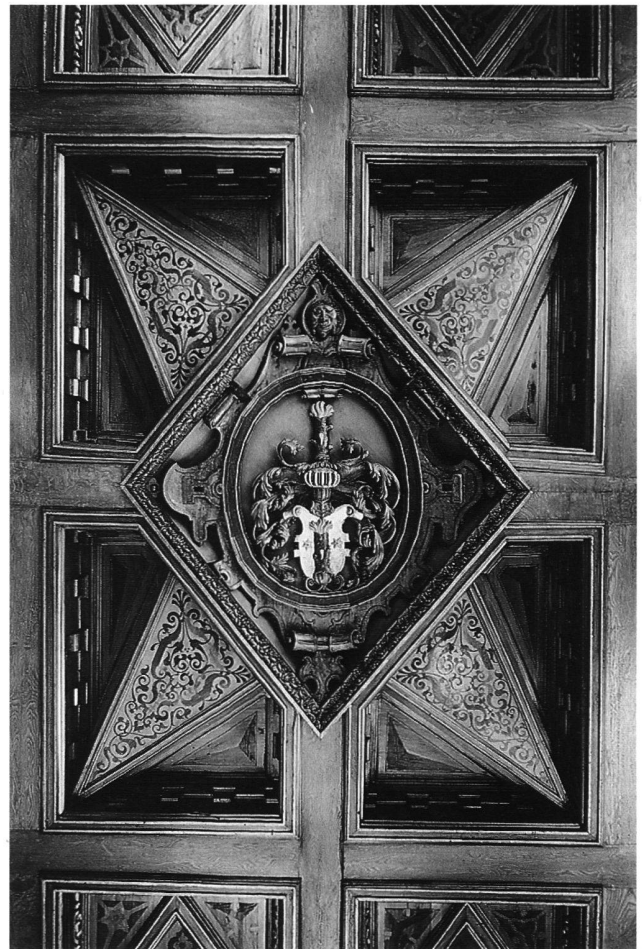
17: Burgistein, Festsaal, Mittelmotiv der Kassettendecke mit reich eingelegten Mauresken und geschnitztem Beschlägwerk. Das Wappen Graffenried stammt wohl aus dem 19. Jh.
