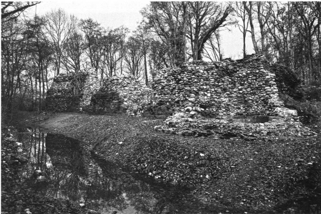
21 : La courtine sud et la tour sud-est après son dégagement avec le fossé en eau au premier plan. – Die südliche Wehrmauer und der Südostturm nach dem Freilegen; im Vordergrund der wiederhergestellte Wassergraben, der die Burg umschloss.
