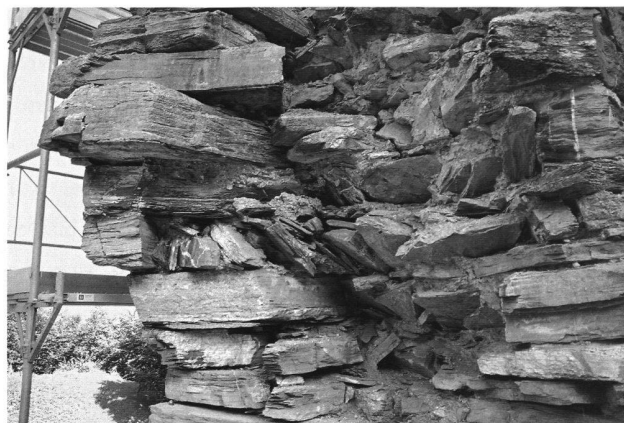
12: Turm, Mauer M1. Locker verfüllter Mauerkern in der Abrisskante, von NW.
