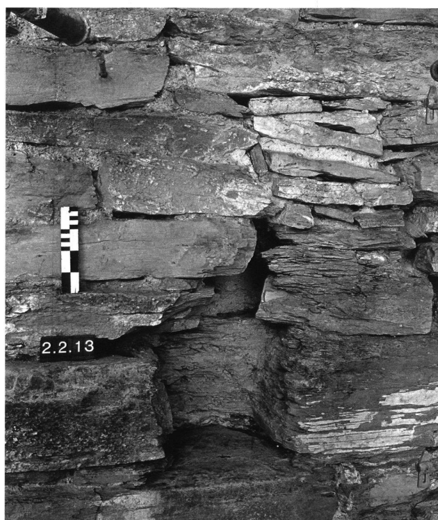
21: Turm, Mauer M2. Die zusammen mit dem Balkenloch 2.2.13 ausgehauene Erweiterung nach rechts oben war nach dem Einlegen des Balkens wieder zugemauert worden, von N.
