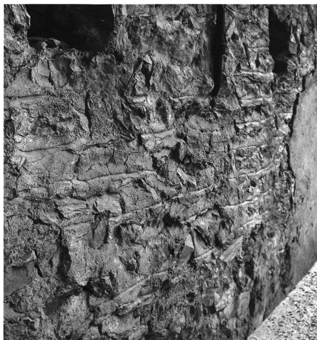
12: Palas-Nordfassade, Detail der Maueroberfläche. Der Rasa Pietra Putz mit horizontalem Fugenstrich entstand beim Bau des Palas.
