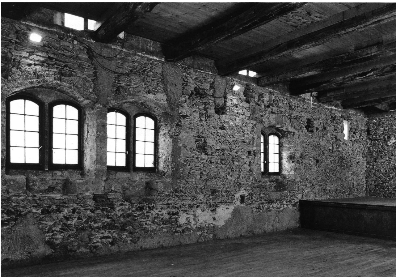
14: Palas-Südmauer, Theatersaal von 1952. Ansicht gegen Südwesten.
