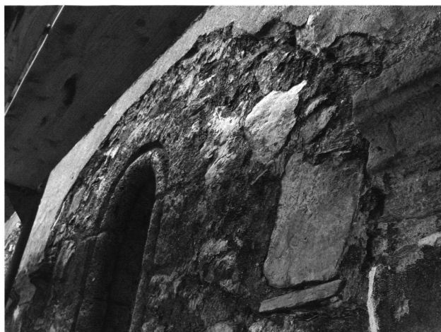
5: Palas-Annex, Nordfassade. Detail der Fenster des ersten Geschosses. Das mit einem Rundstabprofil gerahmte Fenster verdeckt ein älteres, grösseres Fenster, das mit dem Gesims rechts rechnet.
