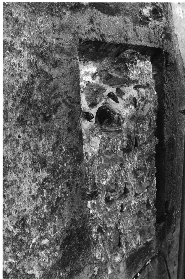
38: Palas-Annex, Südwand. Vermauertes Fenster mit profiliertem Tuffsteinrahmen (doppelte Kehle). Das Fenster entstand gleichzeitig mit dem zwischen Palas und Treppenturm eingefügten Feuerraum. Es wurde 2006 durch eine Türe ersetzt.
