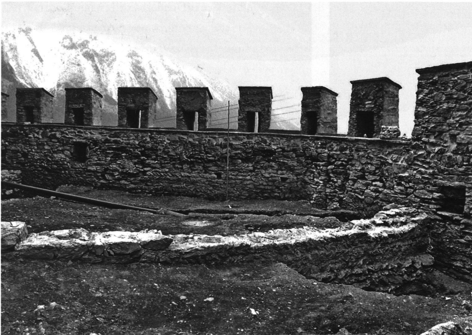
20: Annexbau westlich des Turms. Die Zinnen wurden auf die Reste einer abgebrochenen Gebäudefassade gestellt. Aufnahme von 1988 anlässlich der Ausgrabungen im Hof, Blickrichtung gegen Süden.
