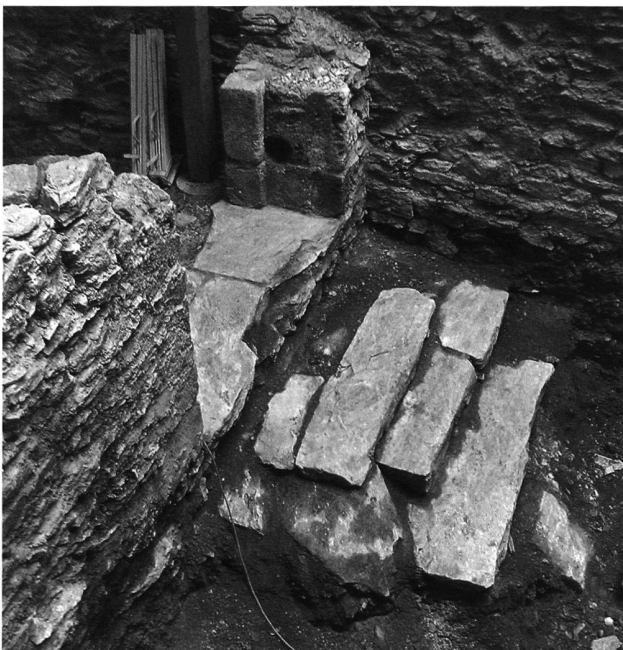
23: Palas-Annex, Kellereingang. Die Stufen wurden 2005 für den Einbau von Sanitäranlagen abgebrochen.
