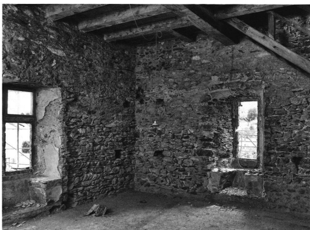
33: Turm, Nordostecke des 3. Geschosses. Links angeschnitten das Kreuzstockfenster
