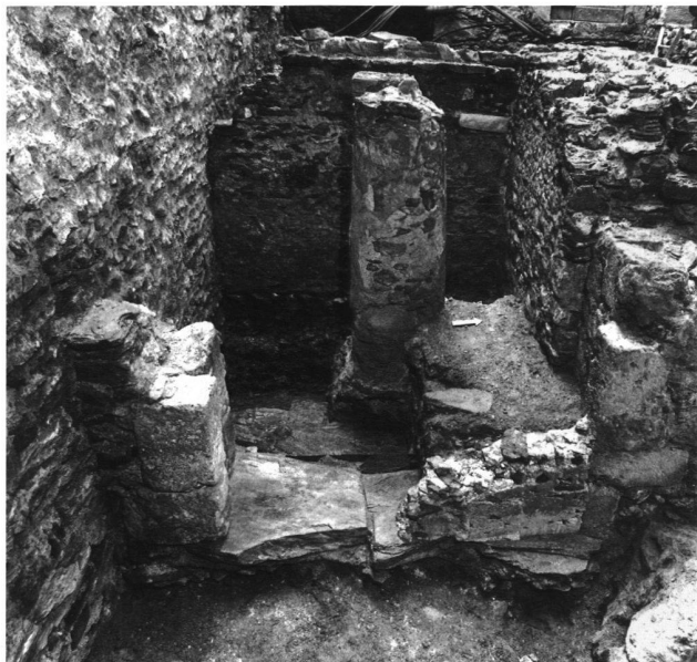
36: Palas-Annex, Kellereingang. Nach Aufgabe und Verfüllung des Kellers wurde das Kellerportal verkleinert und diente als Eingangstüre einer Wendeltreppe. Letztere wurde 2005 für den Einbau der Sanitäranlagen abgebrochen. Aufnahme von 1989, gegen Westen.
