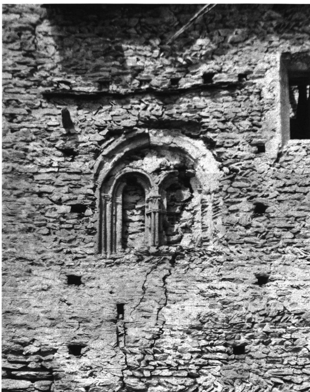
10: Palas-Südfassade. Detail der romanischen Bifore. Über dem Fenster sind die vorkragenden Steinplatten des ehemaligen Satteldaches zu erkennen. Darüber steht die Sockelmauer des Zinnenkranzes mit den Ausgusslöcher, darunter (links) eine Steinkonsole der Dachrinne. Aufnahme von 1937.
