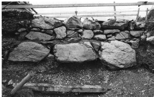
6: Feindseitiger Mauermantel der Letzi Beglingen, von N.
