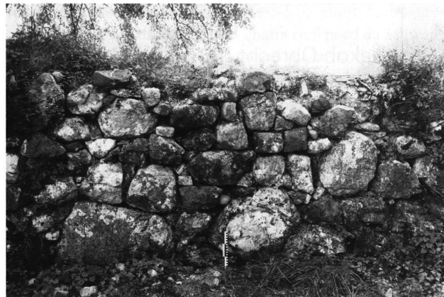
3: Gut erhaltener feindseitiger Mauermantel der Letzimauer im Rautifeld, von N.
