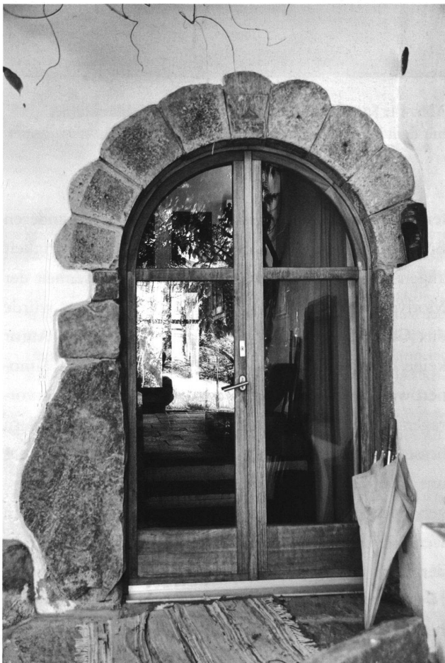
Abb. 10: Soazza GR, Bogen C. Der heutige Zustand entspricht nicht mehr demjenigen, den Simonett 1964 beschrieb. Der Bogen besitzt einen schwer deutbaren Schlussstein. Die restlichen Elemente haben einen fein behauenen Spiegel und glatte Ränder.
