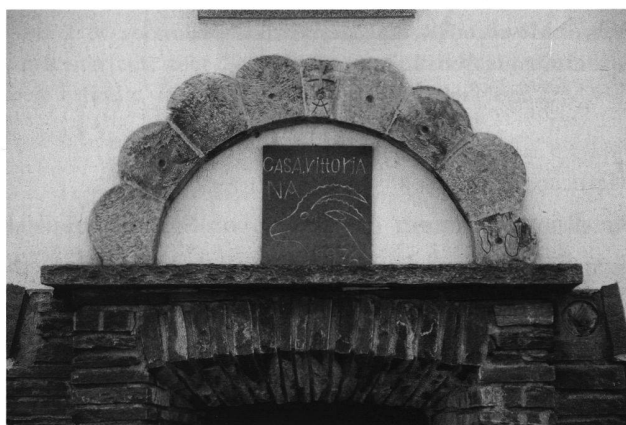
Abb. 7: Soazza GR, Bogen B. Der heutige Zustand entspricht nicht mehr demjenigen, den Simonett 1964 beschrieb. Der Steinspiegel ist mit konzentrischen Kreisen verziert oder mit dem Meissel behauen.
