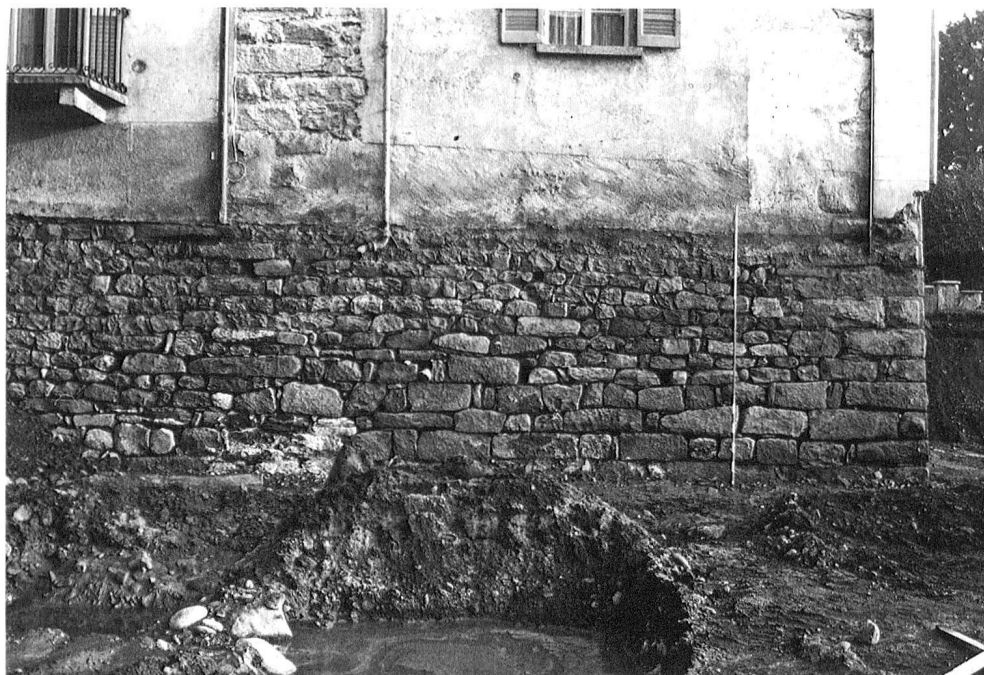
Abb. 22: Ascona, Cast. dei Griglioni. Südwestturm (B). Freigelegtes Fundament von Turm und Kurtine (1967).
