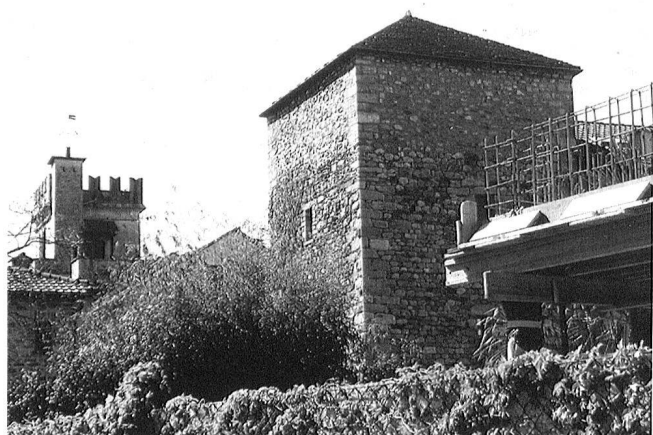
Abb. 16: Ascona, Cast. dei Griglioni. Nordostturm (B), Ansicht von Nordosten. Im Hintergrund der Südostturm (A).
