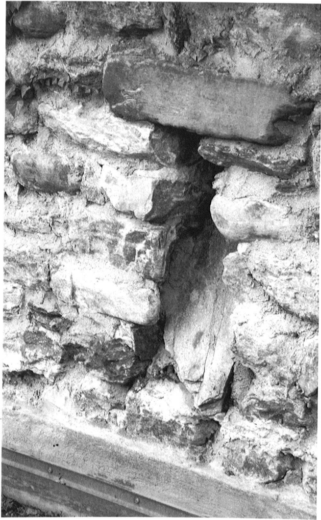
Abb. 24: Ascona, Cast. dei Griglioni. Ausgussöffnung (K) in der Ostkurtine. Vermutlich Fallschacht für einen Abort.
