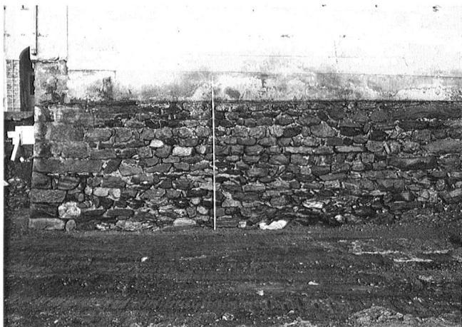
Abb. 21. Ascona, Cast. dei Griglioni. Südwestturm (D). Fundament von Turm und Kurtine freigelegt (1967).
