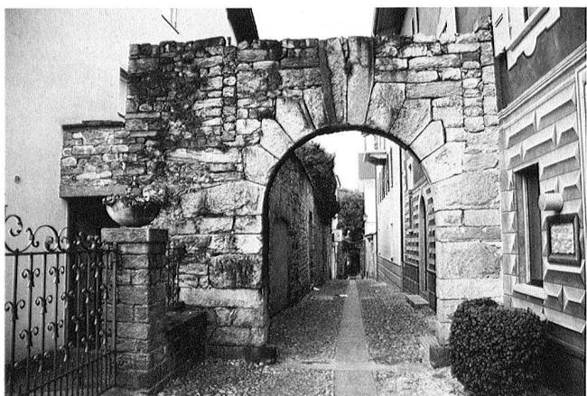
Abb. 26: Ascona, Cast. dei Grigioni. Nordtor, Ansicht von aussen (Norden). Der Rundbogen ist mit zwei Keilsteinen im Scheitel geschlossen. Ebenfalls gut erkennbar sind die beiden zugemauerten Rutenkanäle für eine allfällige Zugbrücke.
