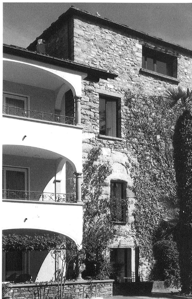
Abb. 17: Ascona, Cast. dei Griglioni. Nordostturm (B) von Süden (Burghof). Im 2. Geschoss (vom Hofniveau an) ist über dem Fenster der Rundbogen des ehem. Hocheinganges erkennbar.
