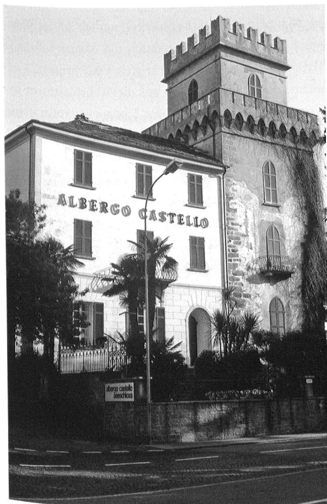
Abb. 18: Ascona, Cast. dei Grigioni. Südostturm (A) mit Zinnenkranz und aufgesetztem Zinntürmchen. Um das Fenster im 2. Geschoss des Turmes sind die Reste einer ehemaligen Fassadenmalerei (Wappen?) erkennbar.
