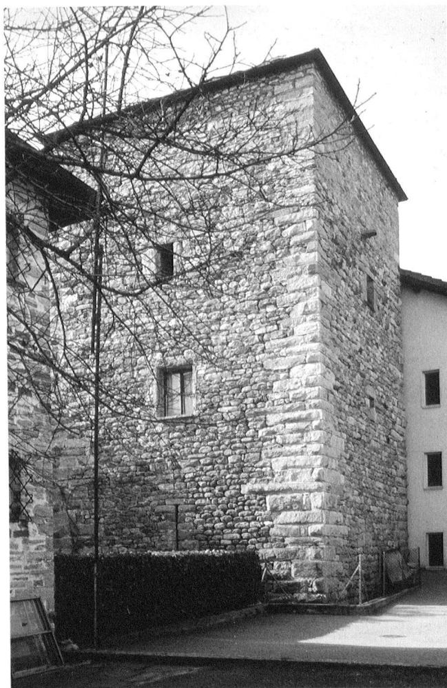
Abb. 19: Ascona, Cast. dei Grigioni. Nordostturm (B). Ansicht der Südostecke mit bossierten Eckquadern.
