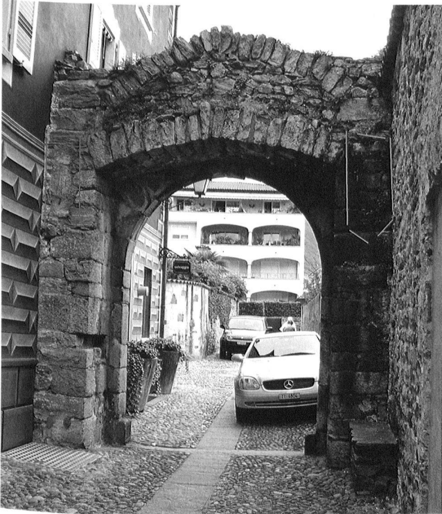
Abb. 27: Ascona, Cast. dei Griglioni. Nordtor, Ansicht von innen (Süden). Der Tordurchgang ist mit einem Flachbogen gedeckt, darüber spannt sich ein Entlastungsbogen. In den markierten Feldern seitlich ist zu bemerken, dass die aussen sichtbaren Rutenkanäle innen nicht erkennbar sind.
