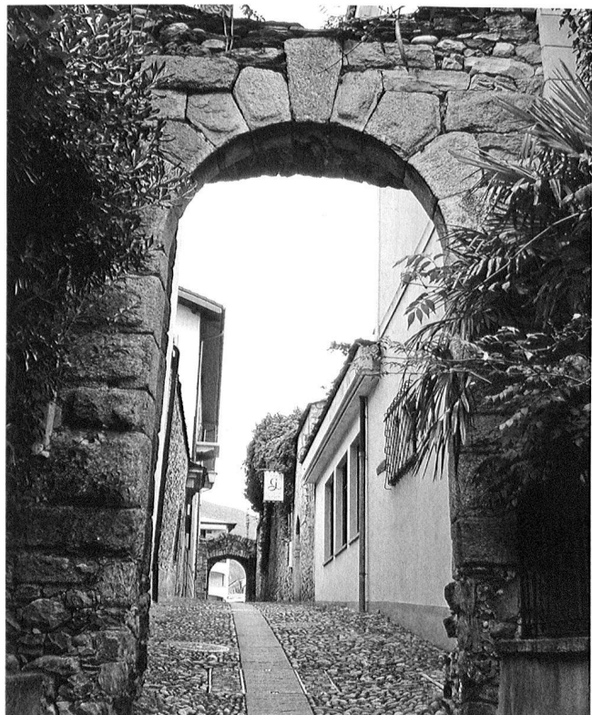
Abb. 29: Ascona, Cast. dei Griglioni. Südtor, Ansicht von aussen (Süden). Durch Absenken der Fahrbahn mussten die Torwangen nach unten verlängert werden.
