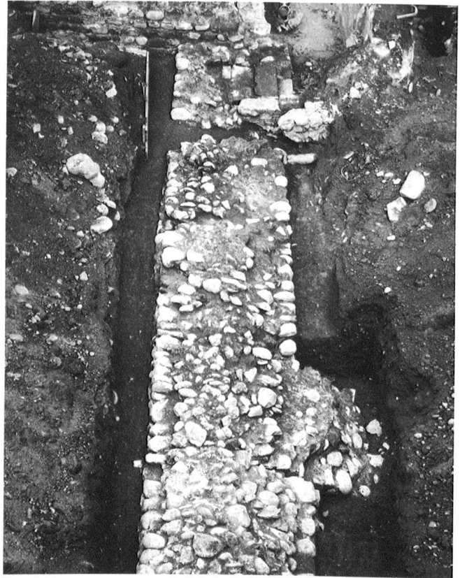
17: Zürich-Lindenhof 1966/67. Jüngeres Pfalzgebäude, Fortsetzung der Westfassade südlich der Kastellmauer. Nach Osten abgehende Binnenmauer mit Setzungsrissen. Blick von Süden.
