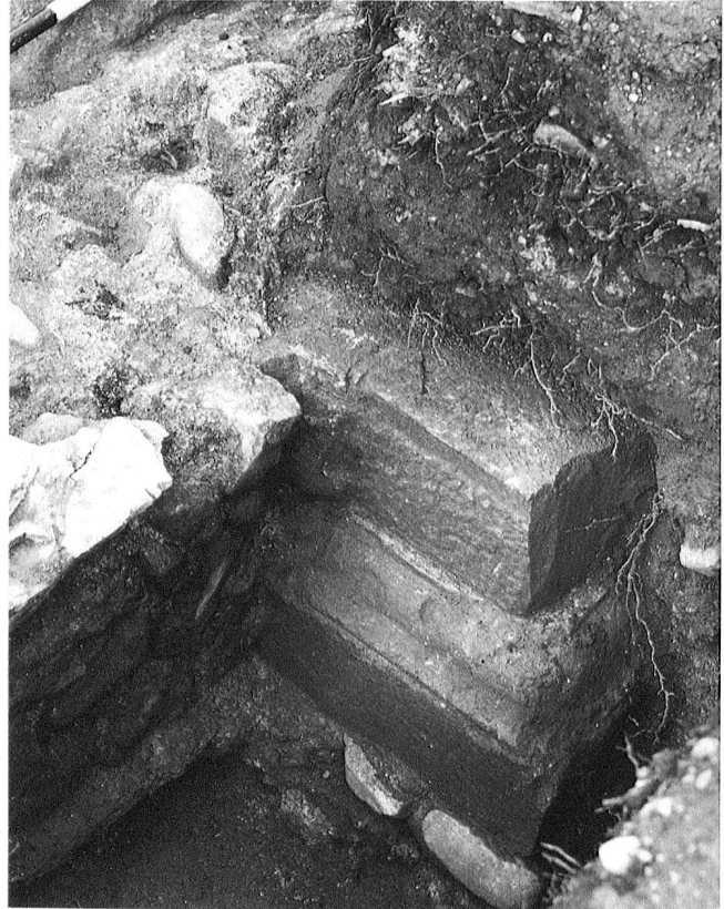
15: Zürich-Lindenhof 1937/38. Jüngeres Pfalzgebäude, Raum D. Nördlicher Pfeiler an der Westwand des Saales.
