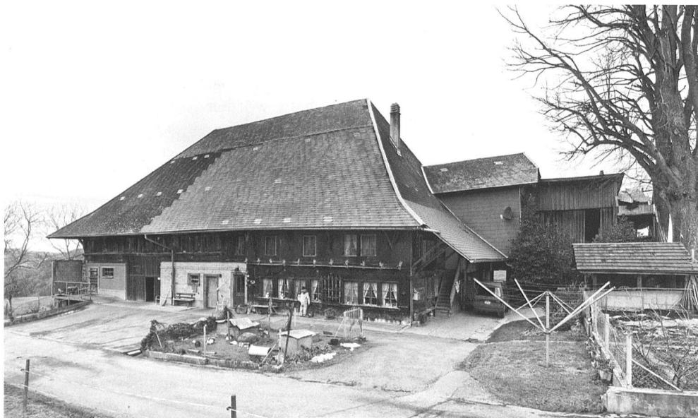
1: Köniz-Grossgschneit. Das Grosshaus wird oft auch als «Heidehuus» bezeichnet. Ansicht der südöstlichen Längsseite im Zustand 2010.
