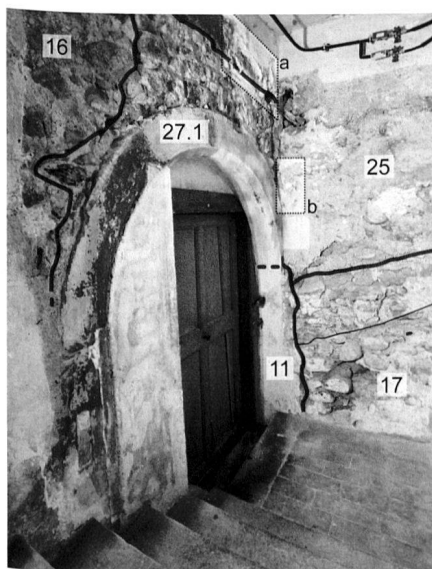
14: Kellerabgang. Die Malerei (26) entstand, als der Kellerabgang noch 2,2 m tiefer lag (16.1). Die Nordfassade (16) und die Kellerabgangsmauer (17/25) treffen exakt auf die Ecke der Mauer (11), welche sich nach Westen ins Nachbarhaus fortsetzt.
