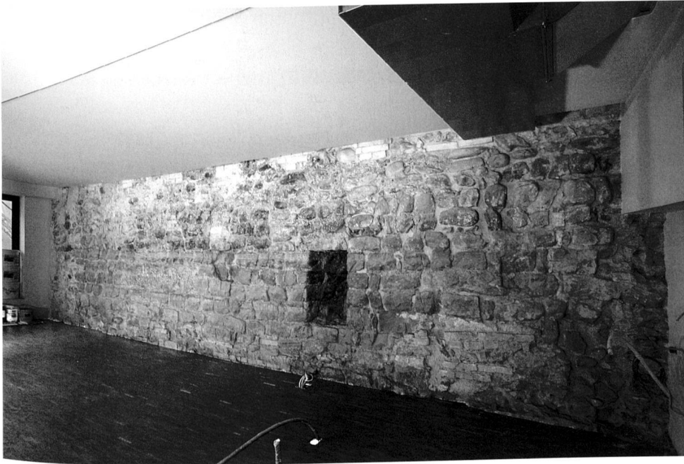
8: West-Innenmauer des Kernbaus II (9) mit der Fensterscharte (9.2) nach dem Umbau.
