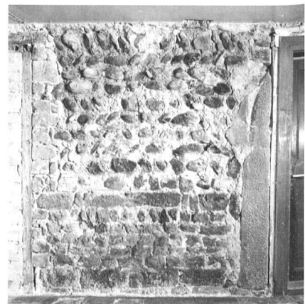
23: Kernbau I, EG, O-Mauer 4 von O.
