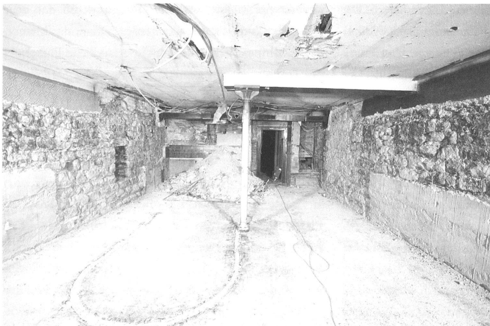
7: Inneres des Kernbaus II (9) während des Umbaus von Süden. Die Nordmauer wurde noch im Spätmittelalter oder in der Neuzeit ersetzt (29).
