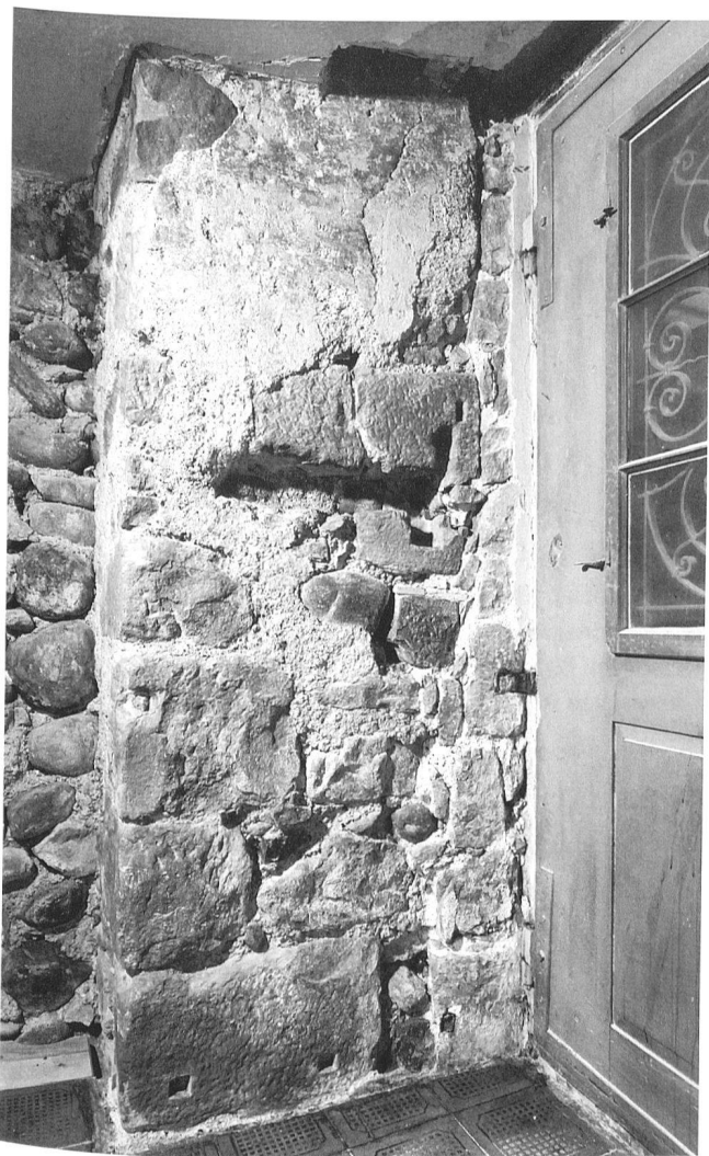
12: Westliches Gewände der Türe (18.1) mit den Verschlusseinrichtungen. Deutlich erkennbar ist aufgrund des Schattens der horizontale Balkenrast.
