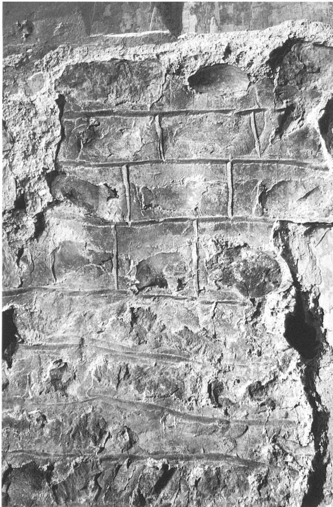
5: Kernbau I, Ost-Innenmauer. Der Fugenstrich weist vor allem horizontale, stellenweise auch vertikale Linien auf.
