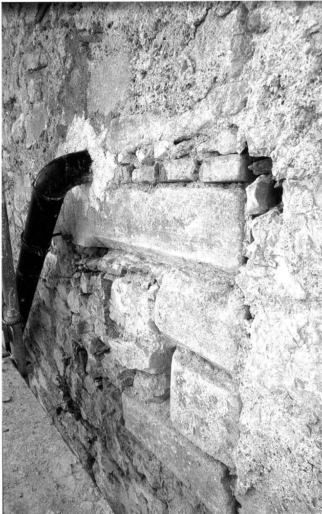
15: Eckverband der 1684 wiederaufgebauten Nordecke des Zwischentraktes, von Norden. In Zweitverwendung gotische Gewände aus Muschelkalkstein.
