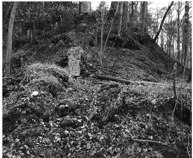
10: Hasenburg Willisau heute. Östlicher Bereich des unteren Burgplateaus mit Blick gegen die Kernburg. Die Natur hat die Anlage zurückerobert. Erosion und Verwitterung haben der Ruine stark zugesetzt. Die 1958/59 freigelegten Mauerzüge sind kaum mehr zu erkennen.
