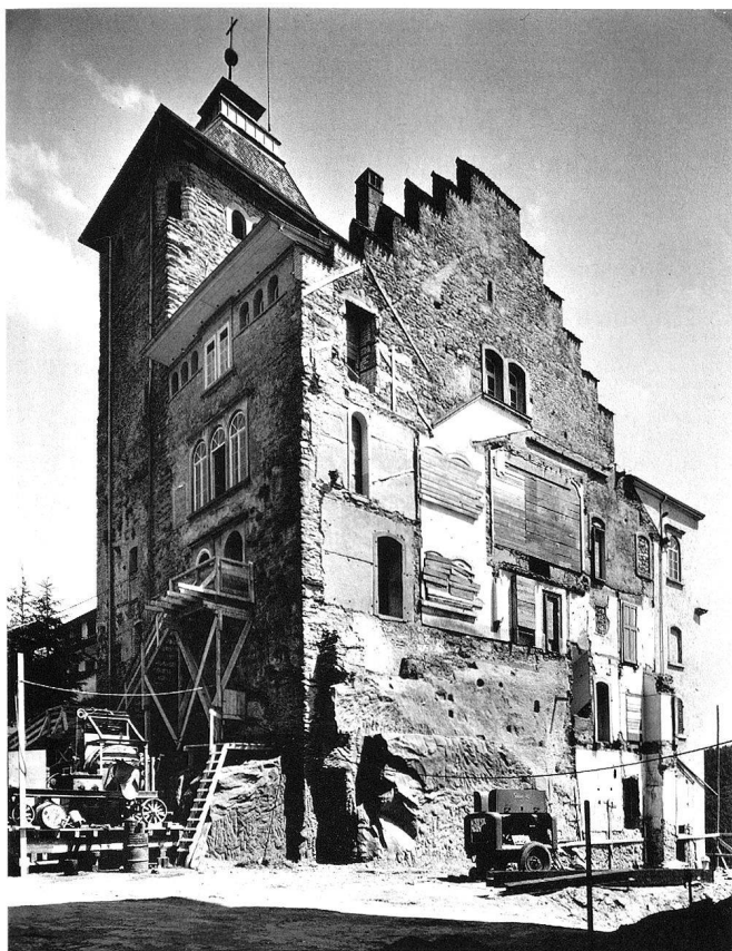
11: Bauarbeiten auf der «Marienburg» bei Wikon 1956. Der in seiner Kernsubstanz mittelalterliche Wohntrakt auf der Westseite des Bergfrieds schien nicht schützenswert und wurde fast vollständig abgebrochen!
