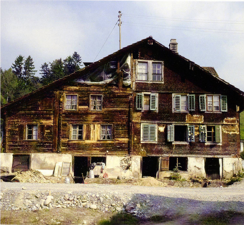
1: Die Südfassade des Hauses «Weid». In der Mitte der Kernbau, links der frühneuzeitliche Anbau, rechts der im 19. Jh. erichtete Hausteil.
