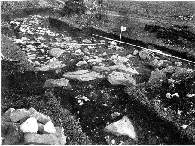
8: Das «Stadtmauer-Fundament» von Richensee präsentiert sich im Befund als unvermörtelte Lesesteinschüttung. Grabungsaufnahme von Schnitt 18, September 1938.
