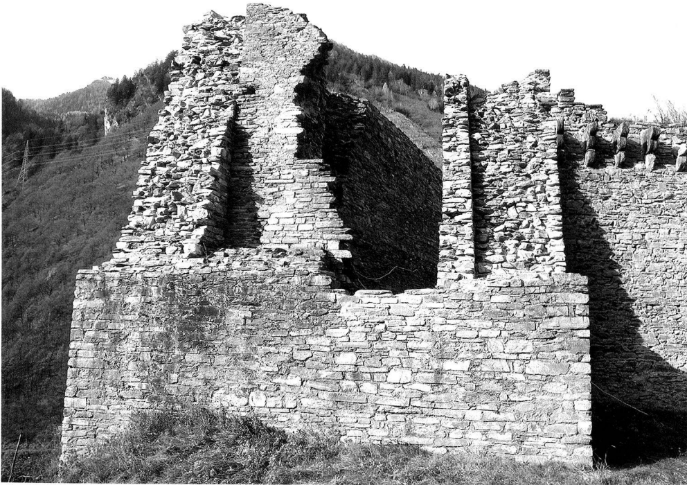
8: Der um 1400 gebaute Südturm wird nach 1480 durch 2 Meter starke Vormauerungen verstärkt, Sicht gegen Norden.
