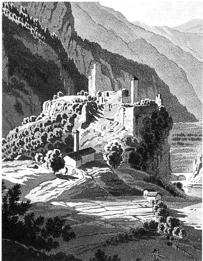
4: Der Ausschnitt aus einer Ansicht von 1825 von Joh. Jakob Meyer zeigt noch eine hoch aufstehende Mauerecke des Hauptturmes.
