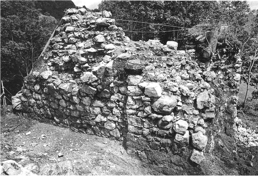
10: Wildhaus-Alt St. Johann SG, Wildenburg. Turm Mauer M4. Frisch vom Schutt befreit, mit deutlich erkennbarer verstärkter Ecke M3/M4, von Südwesten.
