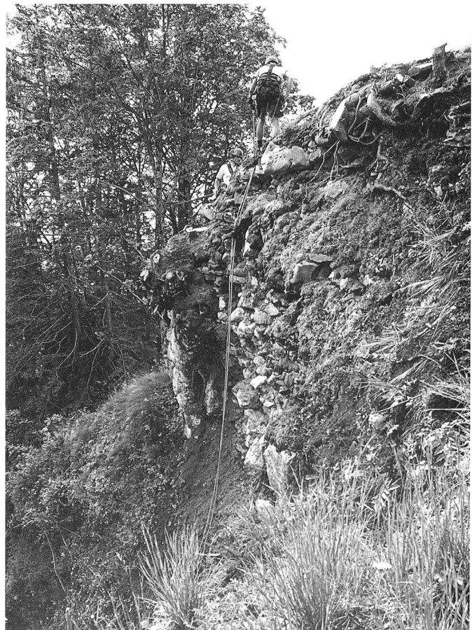
9: Wildhaus-Alt St. Johann SG, Wildenburg. Zwei Seilarbeiter der Firma Hoehenarbeit.ch AG, Grabs, entfernen aus Sicherheitsgründen vor dem Beginn der Gerüstarbeiten lose Steine und Gebüsch aus der nördlichen Turmwand M1, von Westen.
