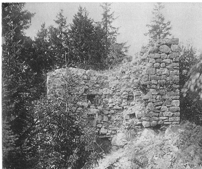
18: Wildhaus-Alt St. Johann SG, Wildenburg. Turm, Mauer M2, Fotoausschnitt. Aufrecht stehende Reste der Ostmauer des Turmes mit den zwei gut erkennbaren Fensteröffnungen. Einige Jahre vor deren Einsturz in den 1920er Jahren, von Osten.
