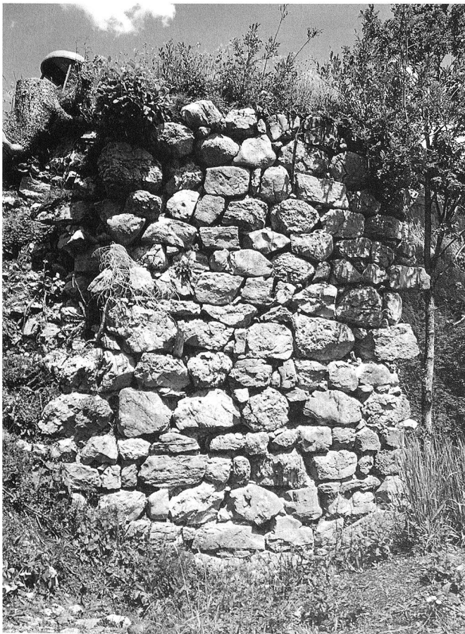
8: Wildhaus-Alt St. Johann SG, Wildenburg. Turm, Mauer M3. Vor Beginn der Arbeiten sichtbarer Rest des äusseren Mauermantels, von Südwesten.
