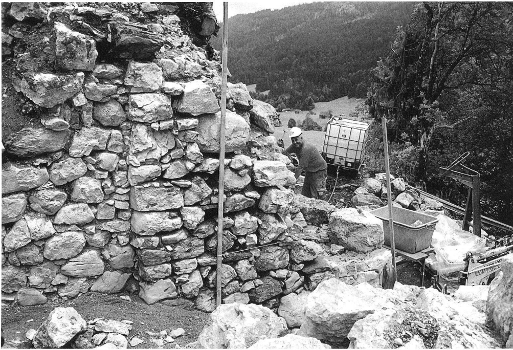
14: Wildhaus-Alt St. Johann SG, Wildenburg. Turm, Ecke M3/M4. Die gegen oben auslaufende Eckverstärkung zu Beginn der Wiederaufbauarbeiten, von Nordwesten.
