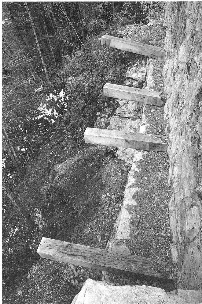
12: Wildhaus-Alt St. Johann SG, Wildenburg. Turm, Mauer M1. Rekonstruierter Fundamentabsatz. Darüber liegen die in die vier vorgefundenen Balkenlöcher eingesetzten Kragbalken aus Eichenholz, von Westen. Sie markieren die Hölzer, die ehemals die hölzerne Zugangsrampe zum Burgtor trugen.
