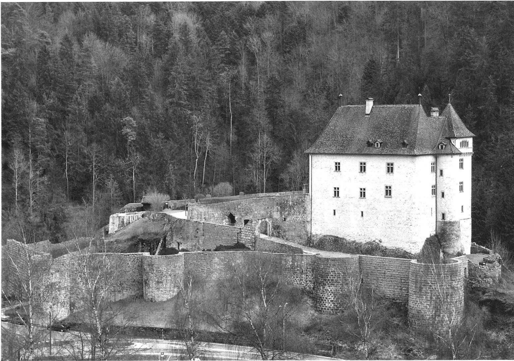
3: Vue actuelle du château depuis le nord.
