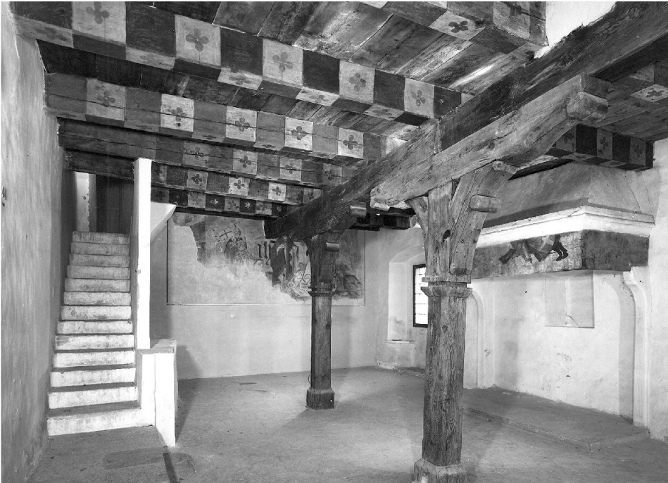
2: Vue d'ensemble de la salle F7 ou Caminata vers le nord-ouest, avec les solives de 1305 environ (peintes vers 1330), les poteaux et le sommier (vers 1415 et 1911), la cheminée (peinte vers 1330) et la peinture murale de la paroi ouest (vers 1470).
