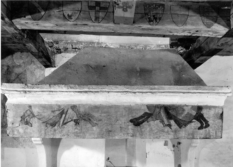
8: La hotte de la cheminée avec le faux-linteau et sa peinture sur bois de la joute entre Dauphiné et Savoie (vers 1330), dans l'état actuel résultant d'un remaniement vers 1442 et des rénovations / restaurations du XX e siècle, chevêtre armorié (vers 1330).
