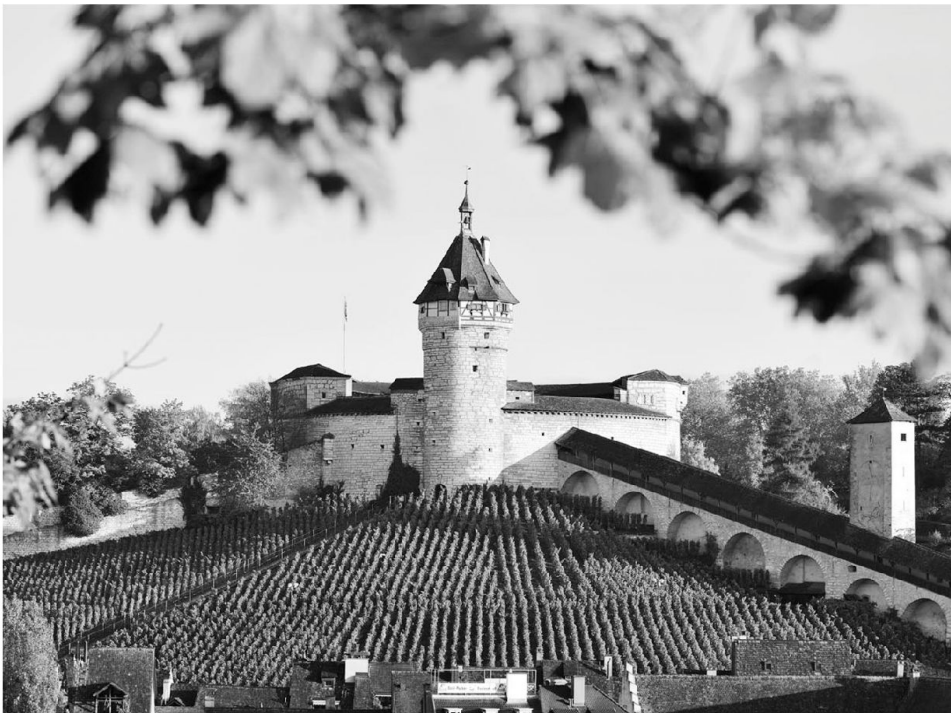
1: Ansicht des Munots von der Rheinseite her, rechts der östliche Wehrgang mit Römerturm.
