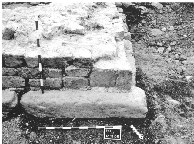
7: Blick von Nordwesten an die Mauerecke des Turmes.
