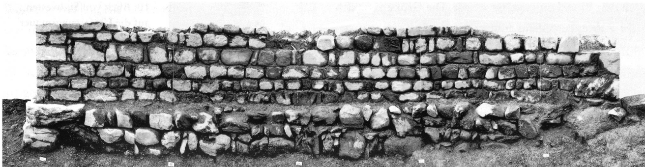
9: Östliche Aussenmauer des Turms.
