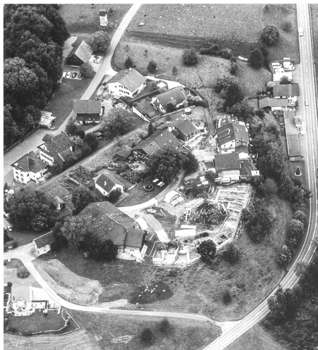
3: Meienberg AG, Blick nach Osten. Flugaufnahme 2005.
