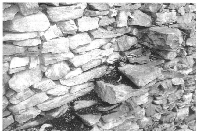
18: Val Bavona, Sott Piodau Lüera. Treppenstufen auf der Aussenseite der Südmauer.
