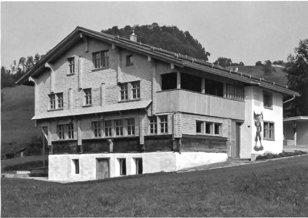
8: Köpli-Haus, Schwyz SZ. Die talseitige Haushälfte ist in Strickbauweise ausgeführt. Der bergseitige Hausteil hingegen besteht aus massiven Bruchsteinmauern.
