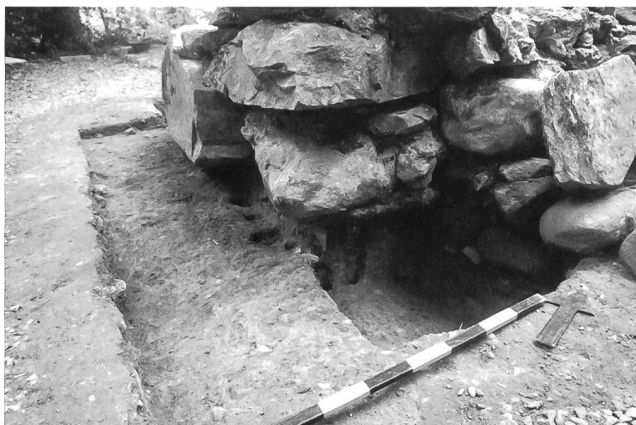
14: Die Vormauerung südlich des Bergfrieds diente wohl zur Aufnahme einer Zugbrücke. Der über die ältere Ringmauer vorkragende Mauerabschnitt wurde mit zahlreichen Staketen unterstützt.
