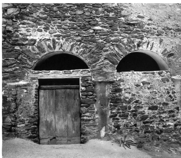
7: Maison Guerrati, façade nord. Détail de l'arcade avant les travaux de rénovation – Detail der Arkaden in der Nordfassade vor der Renovation.
