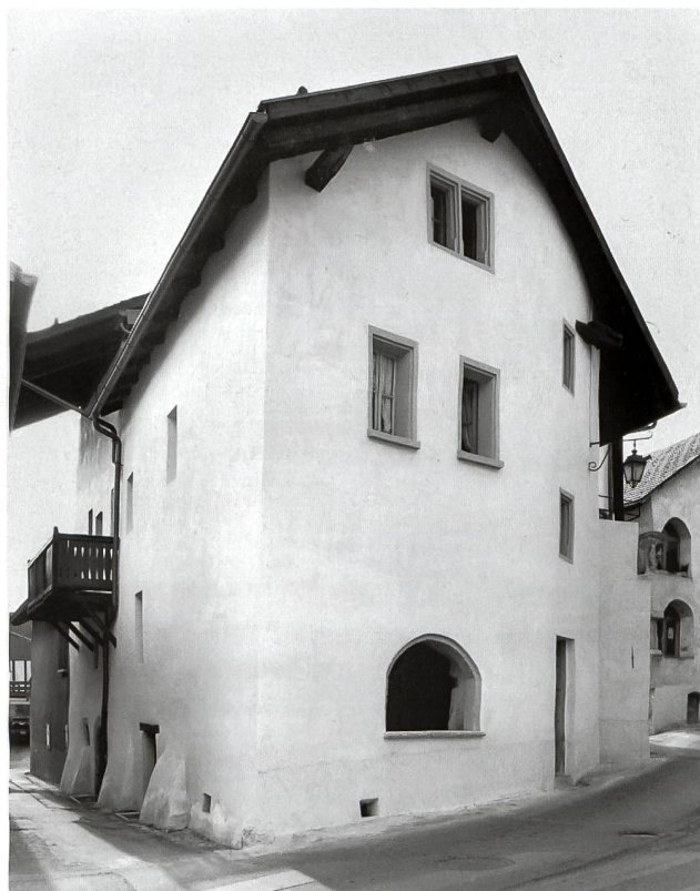
4: Maison Guerrati, façade orientale après les travaux de rénovation – Ansicht der Ostfassade nach den Renovationsarbeiten.
