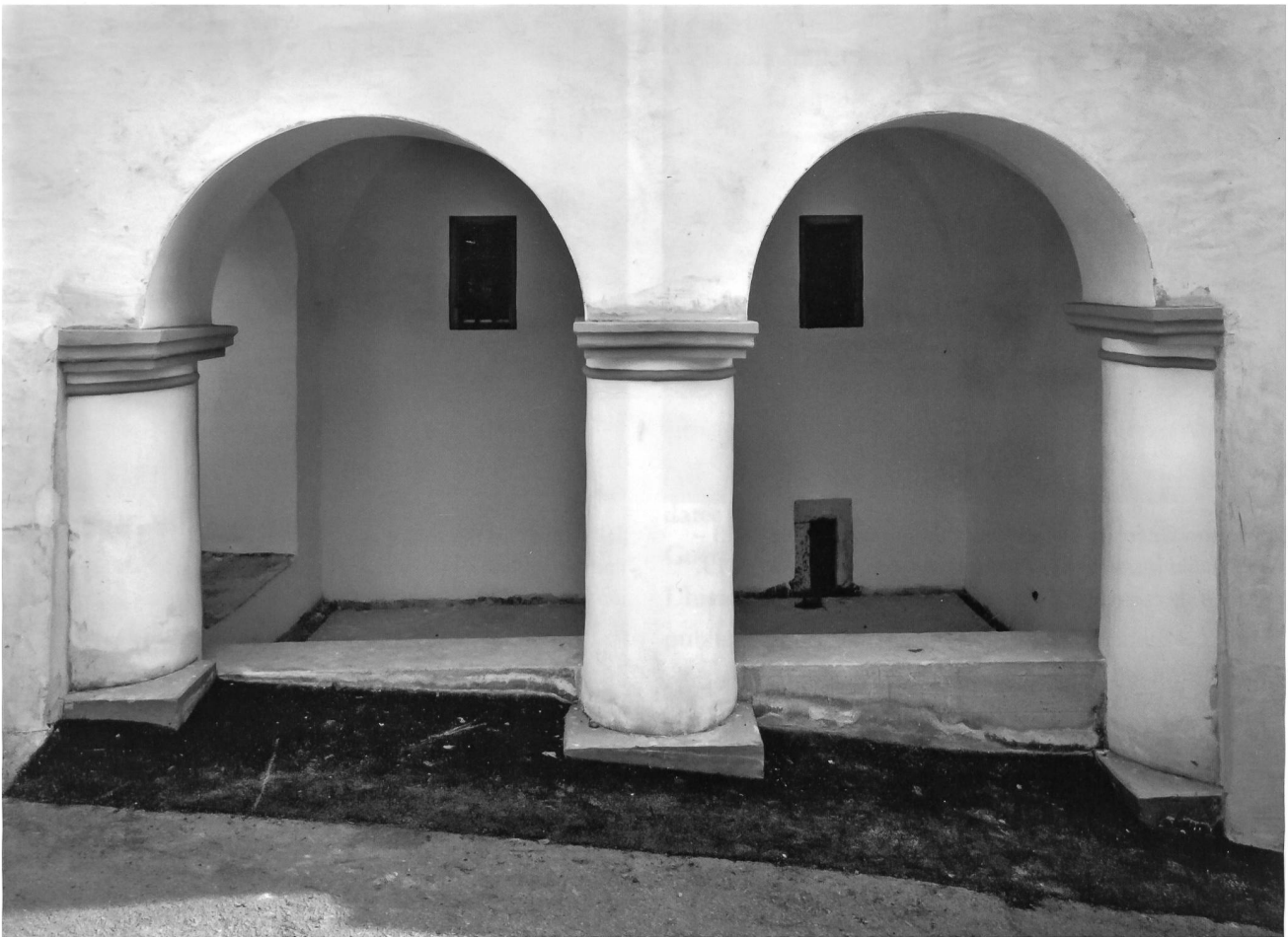
8: Maison Guerrati, façade nord. Détail de l’arcade après les travaux de rénovation – Detail der Arkaden nach der Renovation.
