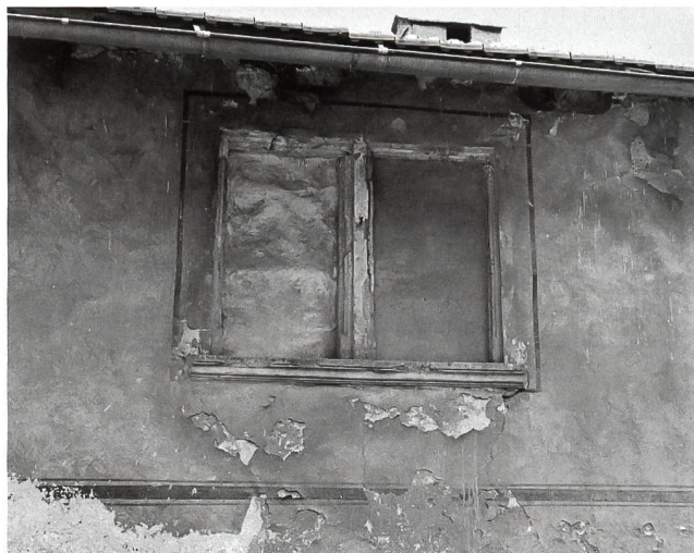
10: Maison Guerrati, façade nord. Détail de la fenêtre au cadre mouluré du 2 e étage, avant les travaux de 2001 – Detail des Fensters in der Nordfassade mit Dekorationsmalerei auf dem Verputz.
