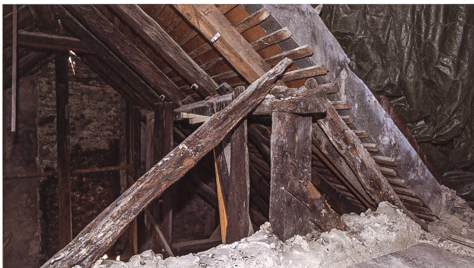
7: Lenzburg AG, Rathausgasse 9. Firstsituation: nachträglich in M24 eingemauerter östlicher Firstständer. Ansicht von SE.
