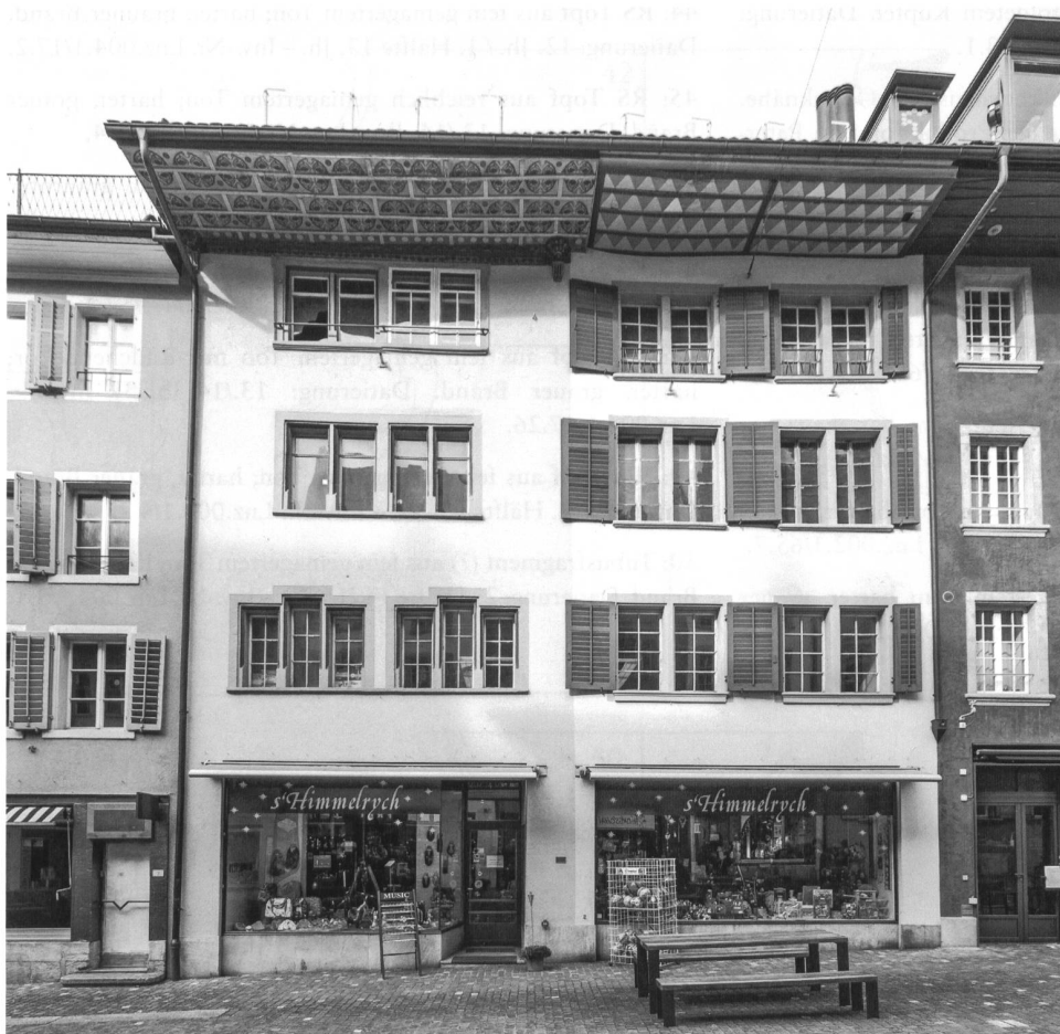
1: Lenzburg AG, Rathausgasse 9. Westlicher und östlicher Hausteil, Ansicht von der Rathausgasse her.
