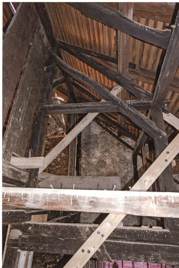
5: Lenzburg AG, Rathausgasse 9. Dachstuhl von 1491/92d: Bundflüchtige Ansicht des oberen stehenden Stuhles des mittleren Querbundes.
