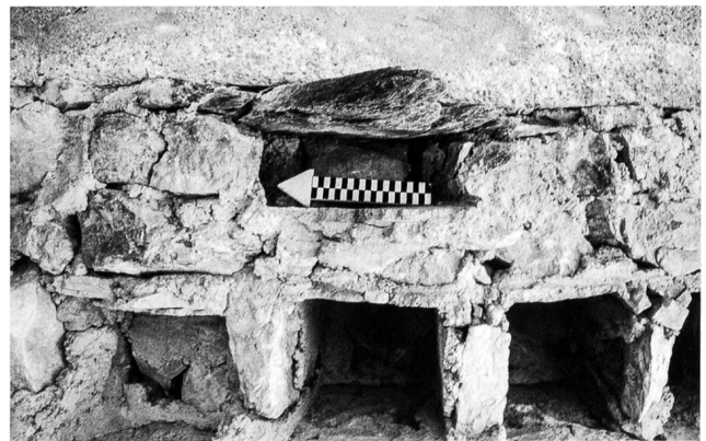
8: Belfort GR. Kanal Pos. 51 über Balkenlage Pos. 26, von Süden.
