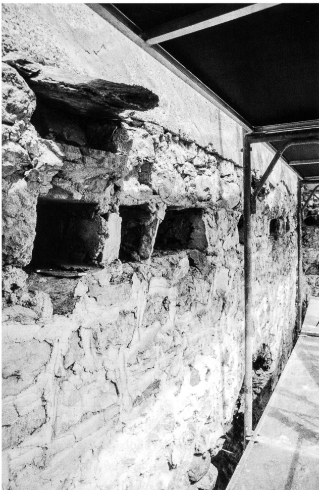
7: Belfort GR. Kanal Pos. 51 mit vorkragender Abdeckplatte, von Südwesten.
