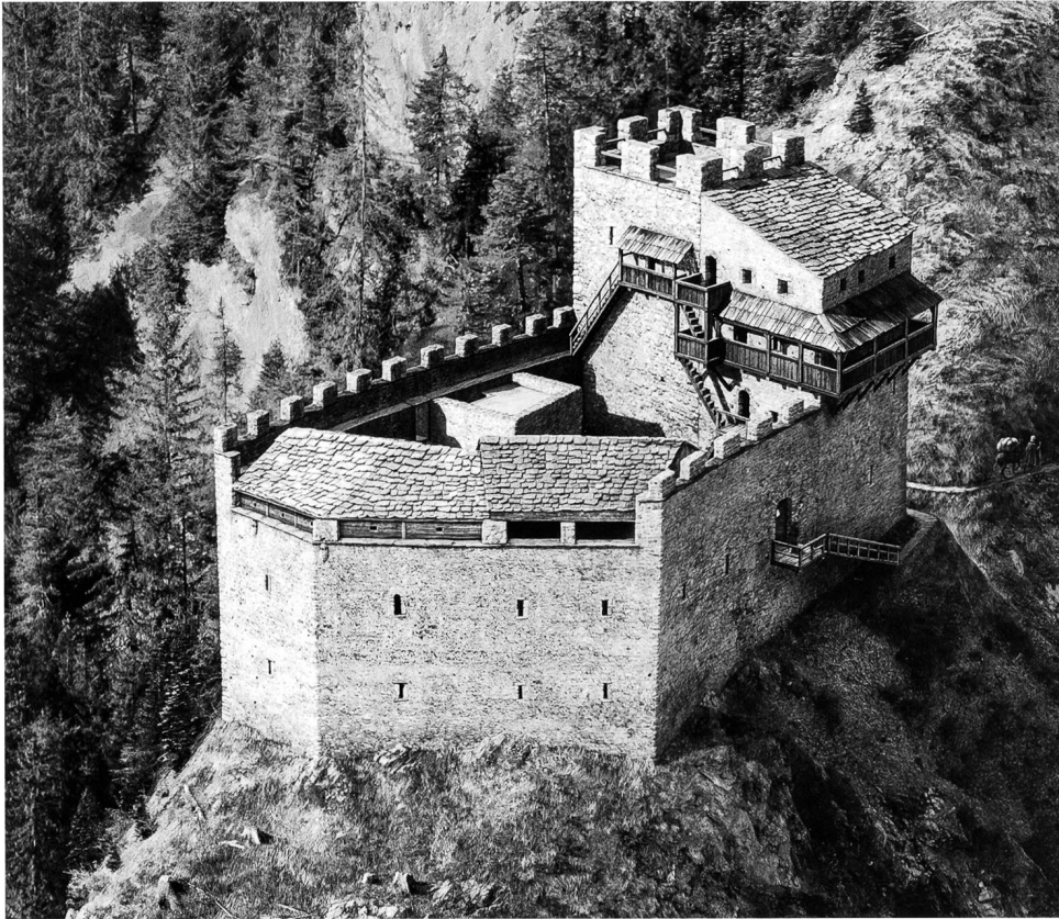
17: Belfort GR. Neuer Rekonstruktionsversuch 2018 nach Lukas Högl. Auf dem Südtrakt wird 1229–33 als drittes Geschoss ein Holzbau mit der in diesem Beitrag dargestellten Fussbodenheizung errichtet.
