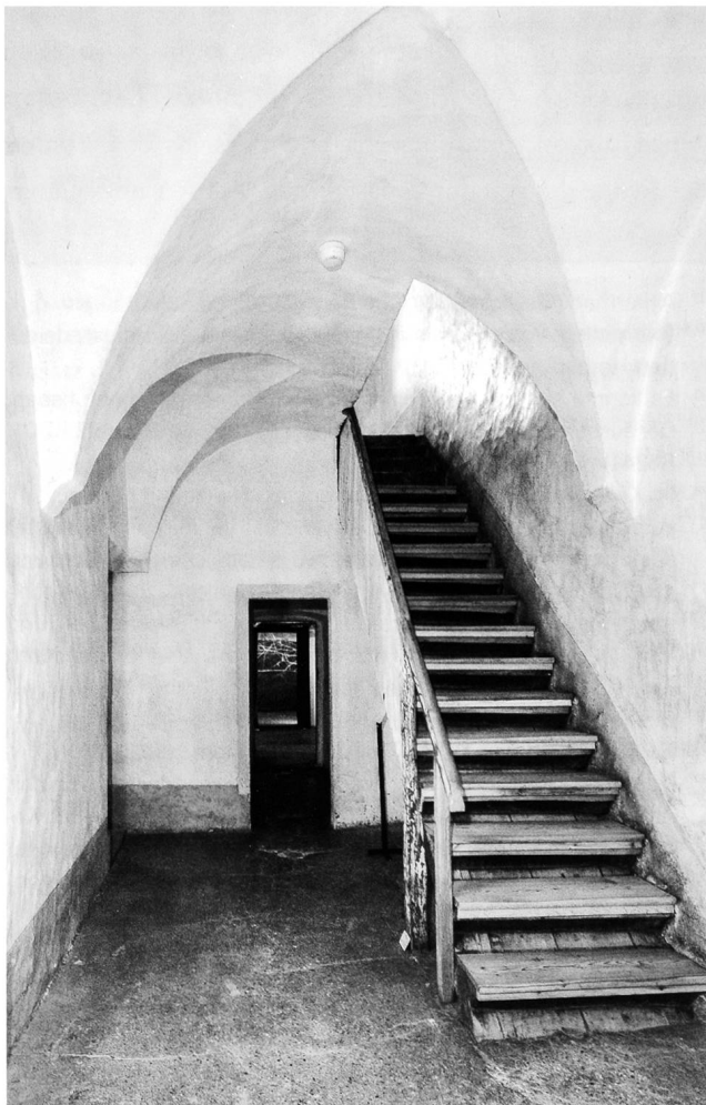
10: Müstair GR, Plantaturm. Gang im ersten Obergeschoss mit der spätgotischen Blocktreppe. Im Hintergrund der Heizraum mit der Tür in die angrenzende ehemalige Küche im «Sakristengebäude».
