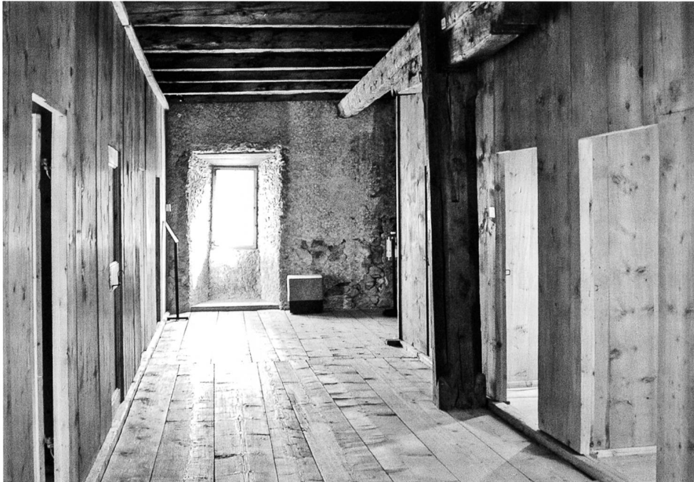
12: Müstair GR, Plantaturm. Das Zellengeschoss mit den Zellen von 1710 und der Decke von 1662.
