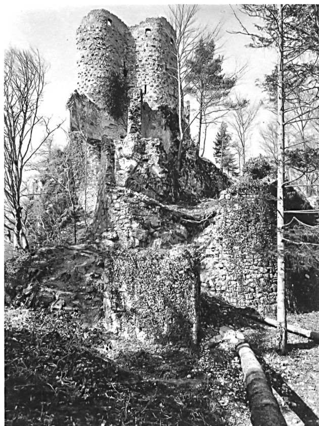
50: Pfeffingen BL. Ostzugang mit dem Pfeiler der Brücke. Fotografie von 1931.
