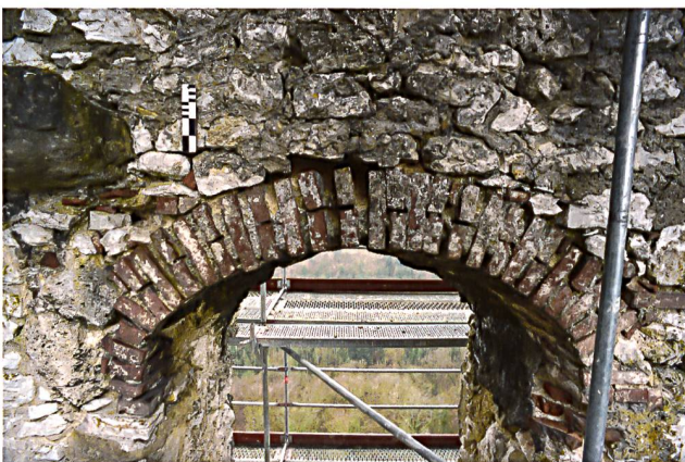
46: Pfeffingen BL. Wohnturm, Innenseite der Südfassade, erstes Obergeschoss. Im 19. Jh. eingezogener Bogen aus industriell gefertigten hart gebrannten Ziegelsteinen. Zustand vor der Sanierung 2013.
