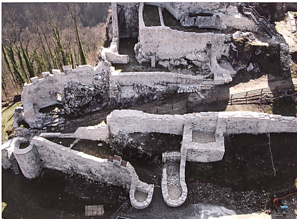
33: Pfeffingen BL. Übersicht des östlichen Bereichs der Burganlage. Im Vordergrund das Nordtor mit der östlich anschliessenden Nordostmauer, die zum Osttor läuft. Im Hintergrund links die südwestlich an das Osttor anschliessende südöstliche Umfassungsmauer. Foto nach der Sanierung 2016.
