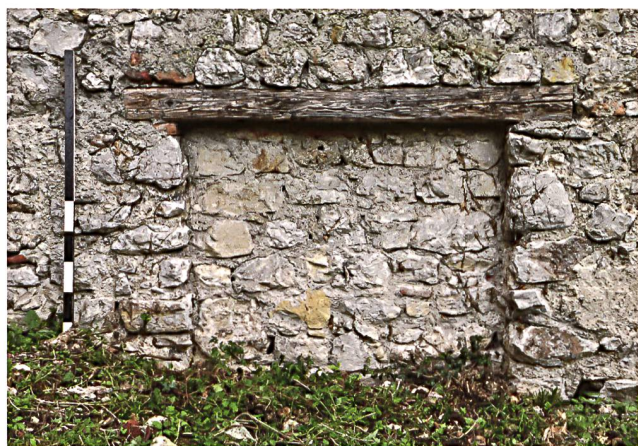
53: Pfeffingen BL. In den 1930er Jahren mit 2/3 der Mauerstärke zugemauertes Fenster im Osten der südlichen Zwingermauer. Foto vor der Sanierung 2013.
