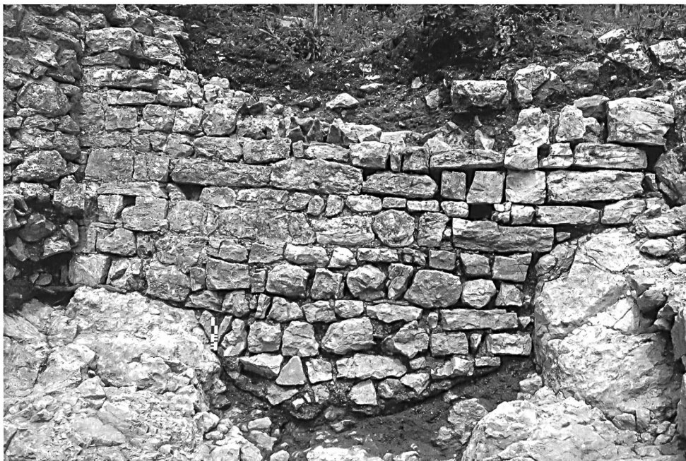
8: Pfeffingen BL. Mauer M911 südlich des Wohnturms. Partien des Mauerwerks erinnern an Mauerwerk des 11. Jh. Blick nach Norden, 2014.
