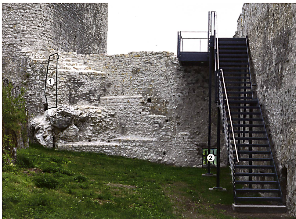
30: Pfeffingen BL. Verbindungsmauer zwischen dem Wohnturm und der Südmauer des Zwingers. 1: Ansatz der Mauer, in der sich das innere Tor befand / 2: Schlupftor, Zustand nach der Sanierung 2016.
