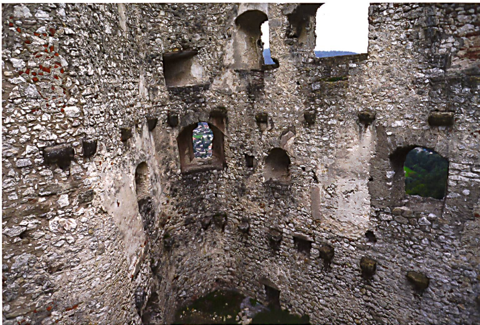
16: Pfeffingen BL. Nordostecke des Wohnturms, 2012 vor der Sanierung. Im ersten Obergeschoss das nach Osten gerichtete Fenster der Kapelle mit den beiden seitlichen Fenstern. Im darüber liegenden Geschoss die Geschützcharte von 1458.
