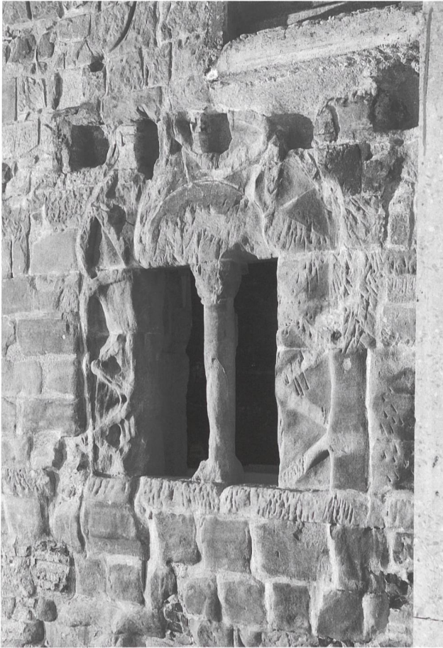
14: Lausanne, maison Charbon. Vue de la baie ouest de la façade sud.
