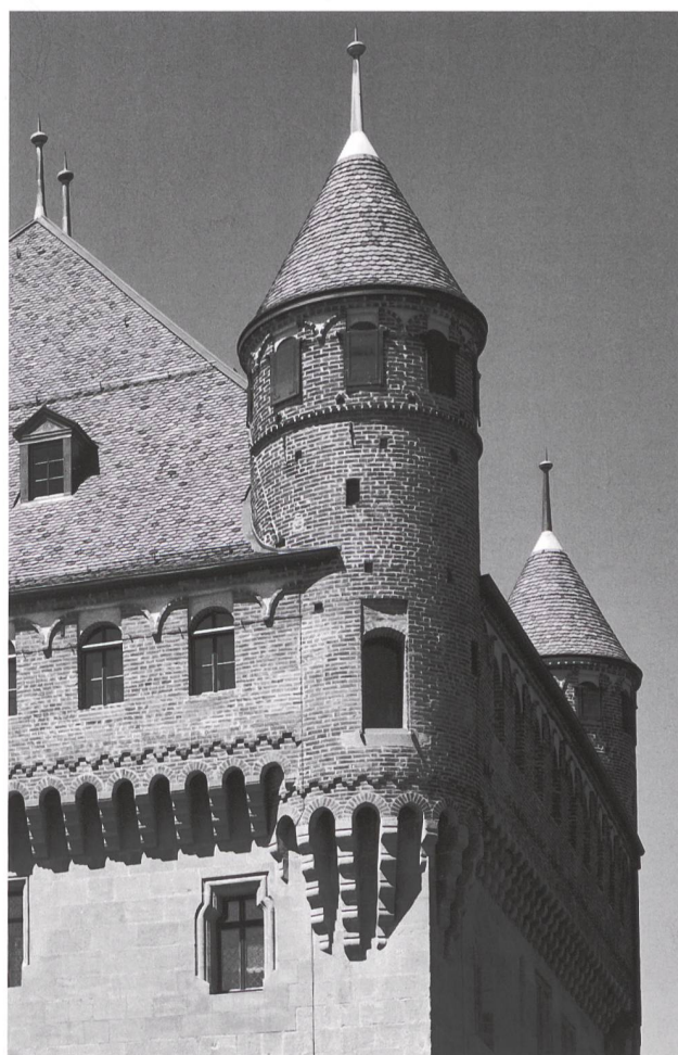
6: Lausanne, Saint-Maire. Tourelle d'angle sud-est «en poivrière» sur mâchicoulis.
